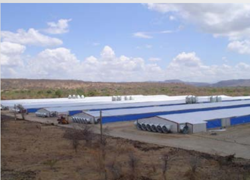
Figura 25. Galpones con sistema de ventilación tipo túnel y extractores que permiten controlar las condiciones medioambientales
