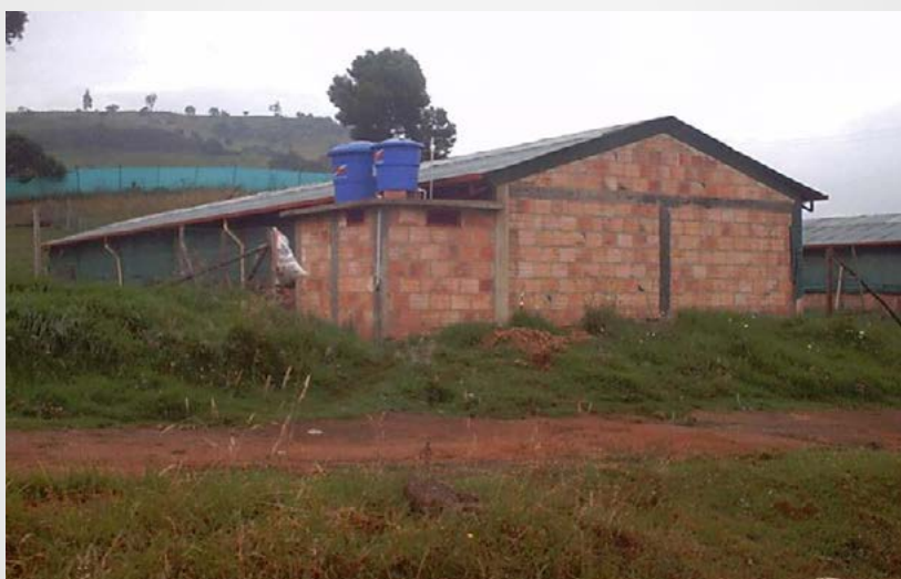
Figura 34. Culata de un galpón avícola en bloque No 5 con tanques de almacenamiento de agua
