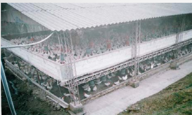
Figura 18. Galpón con estructura metálica y mampostería de dos pisos para ponedoras comerciales
