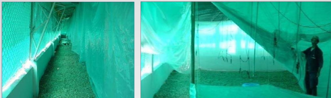
Figura 8. Instalación de cortinas laterales internas y transversales
