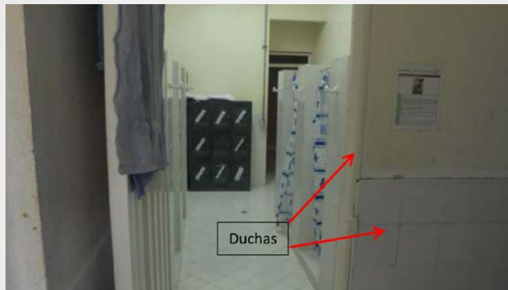
Figura 18. Duchas ubicadas en cada baño
