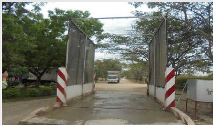
Figura 14. Arco de desinfección para vehículos al ingreso de la planta de incubación
