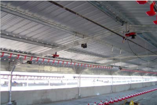
Figura 23. Apariencia del techo interior del galpón con estructura totalmente metálica
