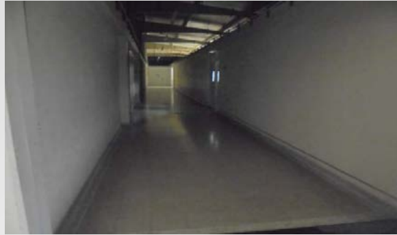
Figura 22. Corredor de acceso a las diferentes áreas de la planta de incubación
