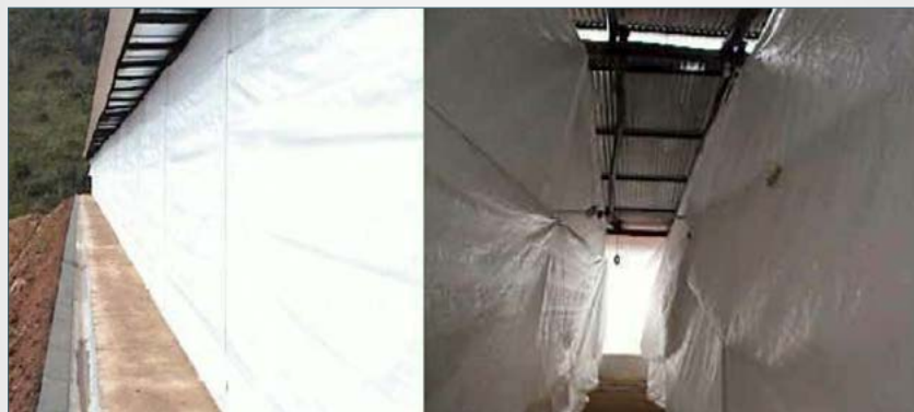
Figura 7. Instalación de cortinas exteriores laterales y transversales
