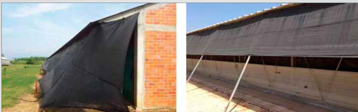
Figura 12. Cortinas laterales adicionales en lote de aves de levante durante un programa de oscurecimiento parcial en galpones abiertos
