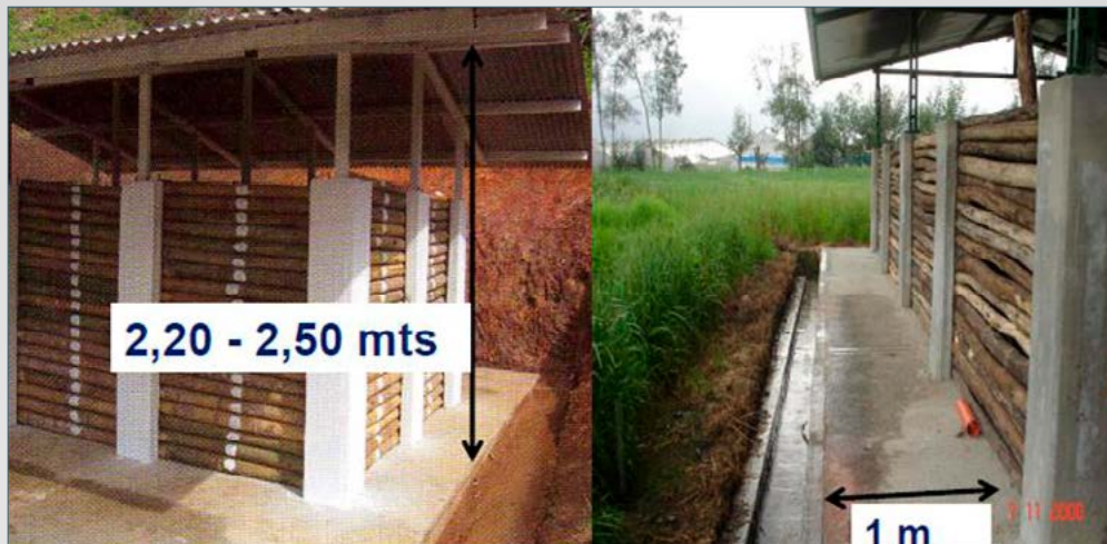
Figura 12. Medidas básicas de un compostero de aves
