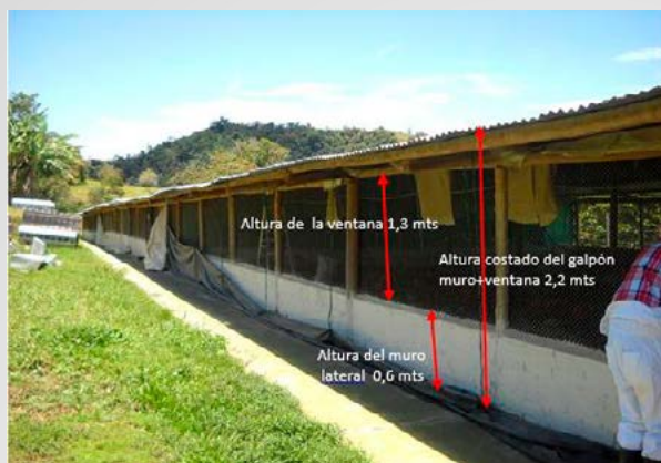
Figura 32. Dimensiones de altura en galpón de clima medio
