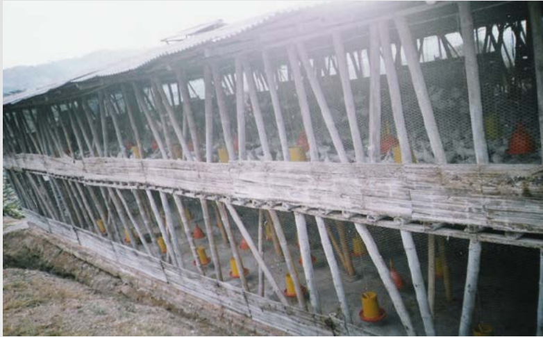
Figura 5. Galpón rústico fabricado en guadua para alojar gallinas en un sistema intensivo
