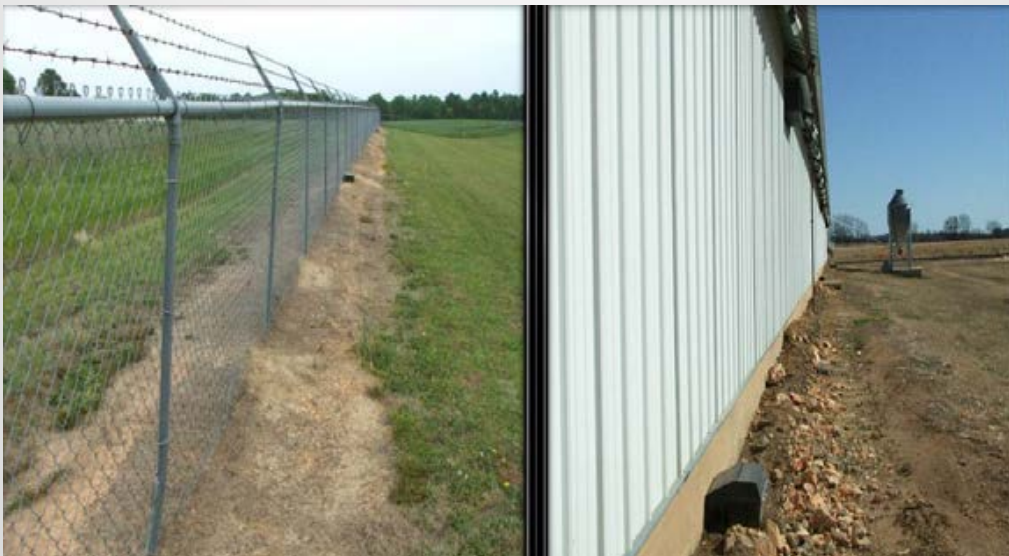
Figura 4. Cerco perimetral delimitando toda la granja y restringiendo el ingreso
