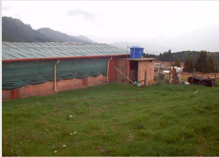
Figura 35. Galpón avícola con puerta de ingreso lateral y tanque de agua con ubicación igualmente lateral
