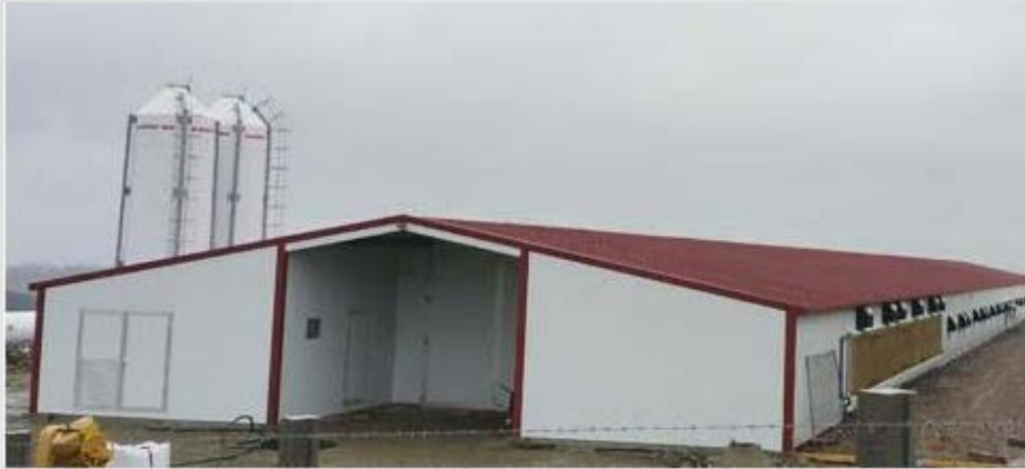
Figura 37. Caseta avícola de pollo de engorde cerrada y con ambiente totalmente controlado
