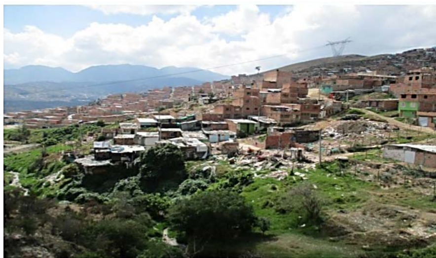
Fotografía 1: Polígono de Monitoreo 125 –Divino Niño, Localidad de Ciudad Bolívar. Afectación por ronda de ríos o quebradas. Tomada de Secretaria de Hábitat 2016
