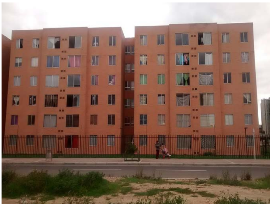
Fotografía 12: Vista lateral derecha. Conjunto El Paraíso Ciudad Bolívar. Elaboración Propia.
