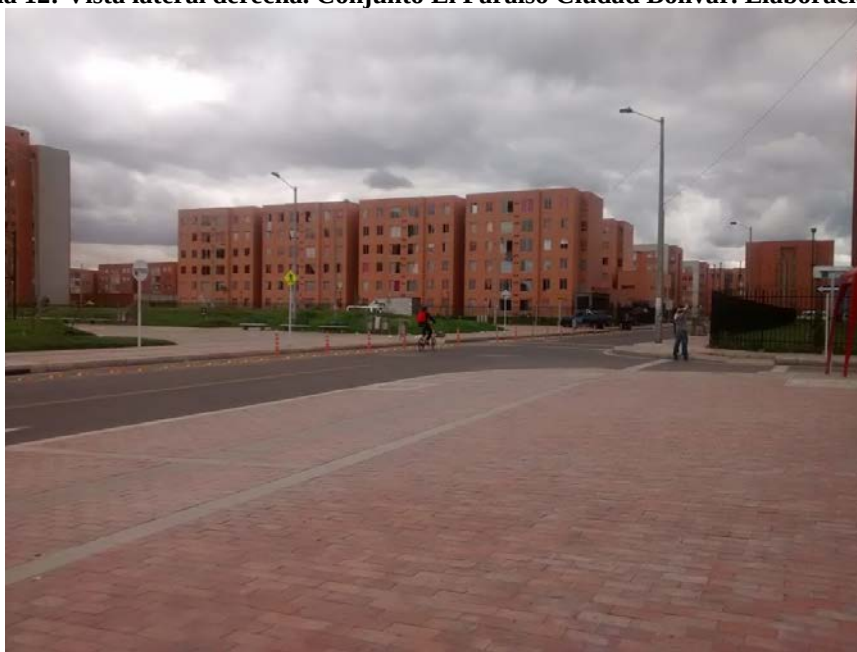
Fotografía 13: Vista lateral izquierda Conjunto El Paraíso Ciudad Bolívar. Elaboración Propia.
