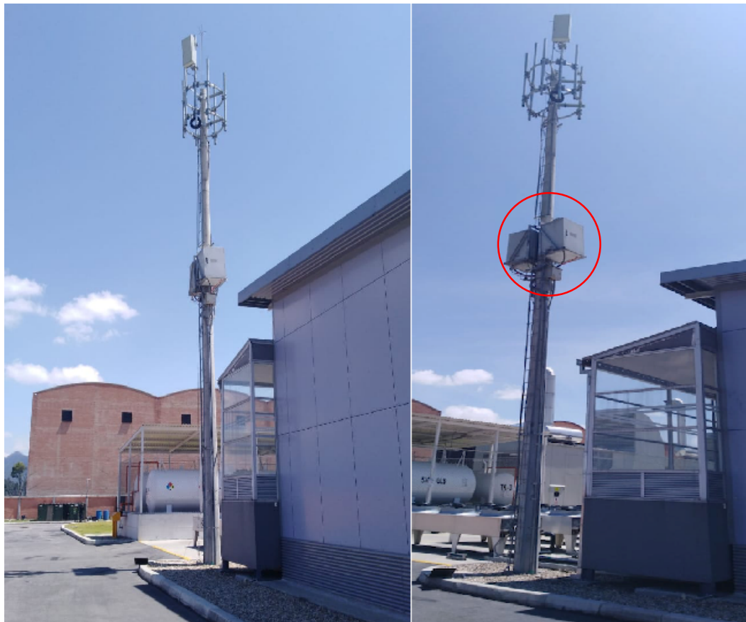
Figura 21. Instalación AAU y BBU. Fuente propia
