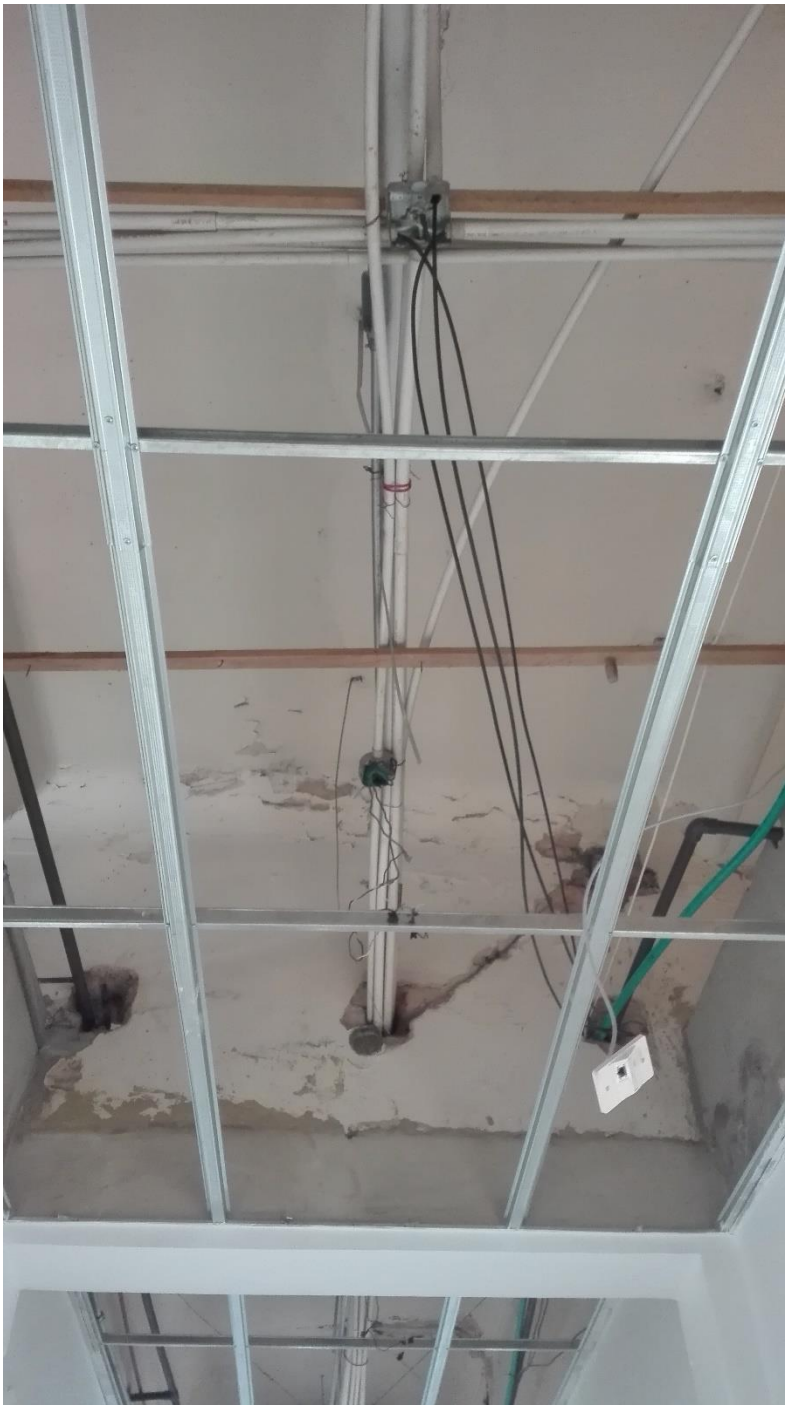
[Fotografía de Autor]. (Bogotá. 2016). Archivos fotográficos del Pabellón. Pabellón Santa Teresa y Manrique del Hospital de San José (Monumento Nacional)- Estructura de Drywall. Bogotá, Colombia.
