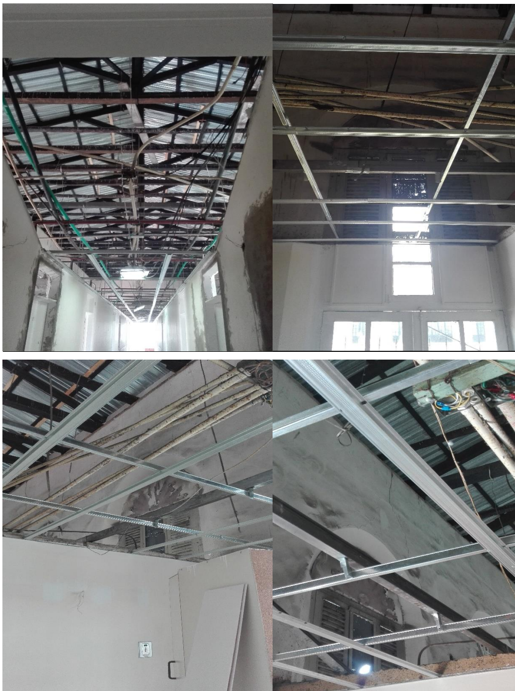
[Fotografía de Autor]. (Bogotá. 2016). Archivos fotográficos del Pabellón. Pabellón Santa Teresa y Manrique del Hospital de San José (Monumento Nacional)-Estructura de techo. Bogotá, Colombia.
