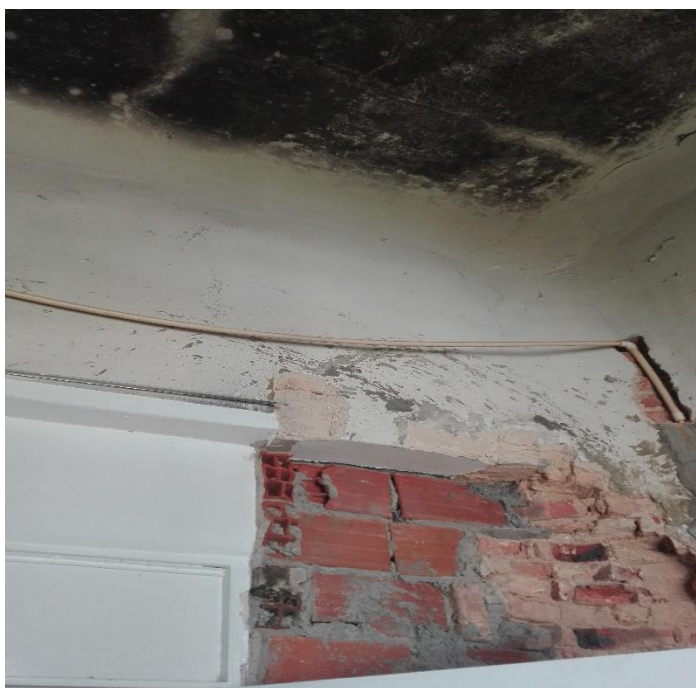
[Fotografía de Autor]. (Bogotá. 2016). Archivos fotográficos del Pabellón. Pabellón Santa Teresa y Manrique del Hospital de San José (Monumento Nacional)- Estructura interna. Bogotá, Colombia.
