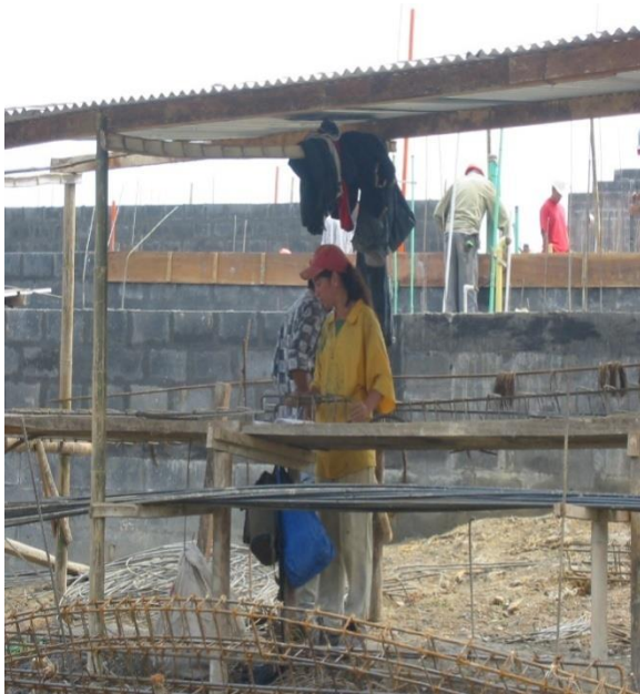
ARMADO DE ESTRUCTURA – INSTALACIÓN Y DILATACIÓN ENTRE MUROS DE SEPARACIÓN CADA DOS VIVIENDAS
