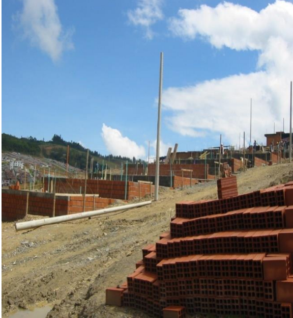
LA UTILIZACIÓN DE LADRILLO ESTRUCTURAL INDISPENSABLE PARA LA APLICACIÓN DEL SISTEMA CONSTRUCTIVO (MAMPOSTERÍA ESTRUCTURAL)
