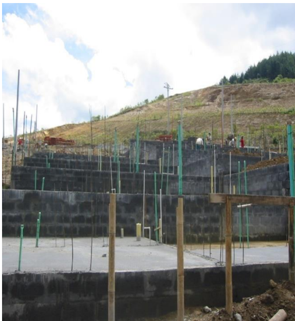
VACIADO DE LOSAS ESCALONADAS INCLUYE REDES ELÉCTRICAS-HIDRÁULICAS Y SANITARIAS
