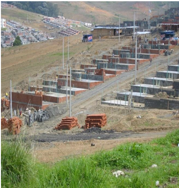
A PARTIR DE LAS LOSAS SE LEVANTAN LOS MUROS REFORZADOS DE CERRAMIENTO
