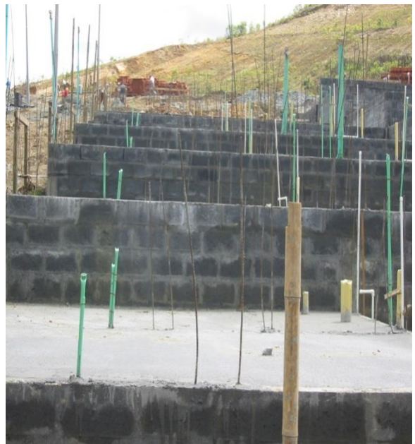
VACIADO DE LOSAS ESCALONADAS INCLUYE REDES ELÉCTRICAS-HIDRÁULICAS Y SANITARIAS
