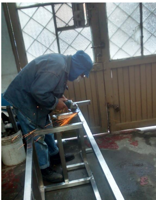
Figura 50 Pulido de la soldadura en las uniones de la estructura. Fuente: Autor
