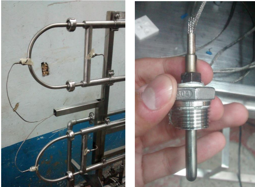
Figura 59 Instalación de termocuplas en los puntos de sensado de temperaturas. Fuente: Autor
