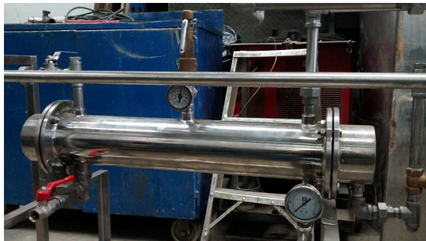
Figura 56 Montaje de las conexiones en el intercambiador de coraza y tubos. Fuente: Autor
