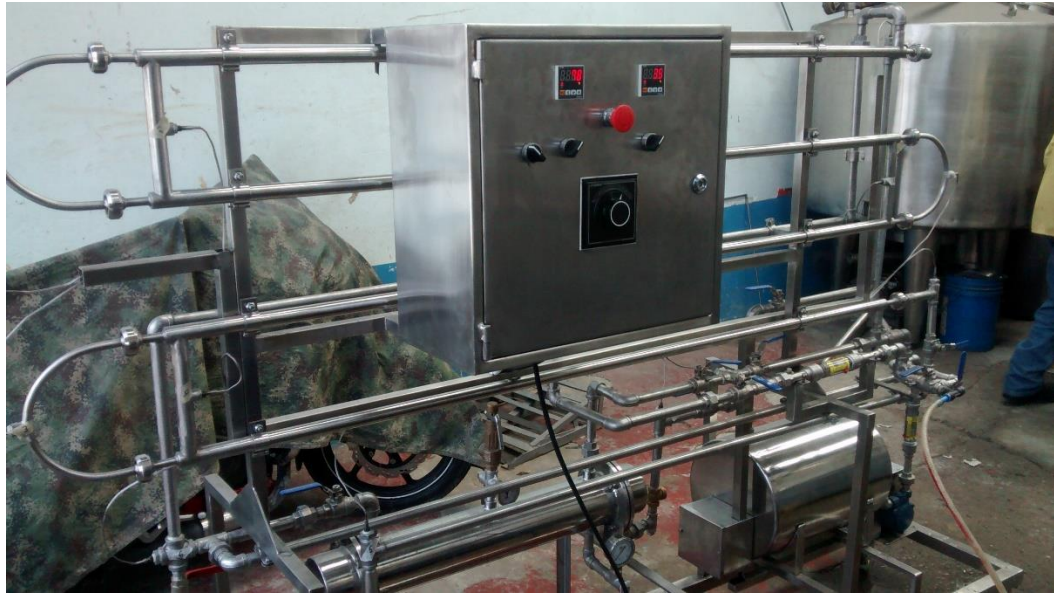
Figura 61 Puesta en marcha del banco y limpieza interna de las tuberías. Fuente: Autor.
