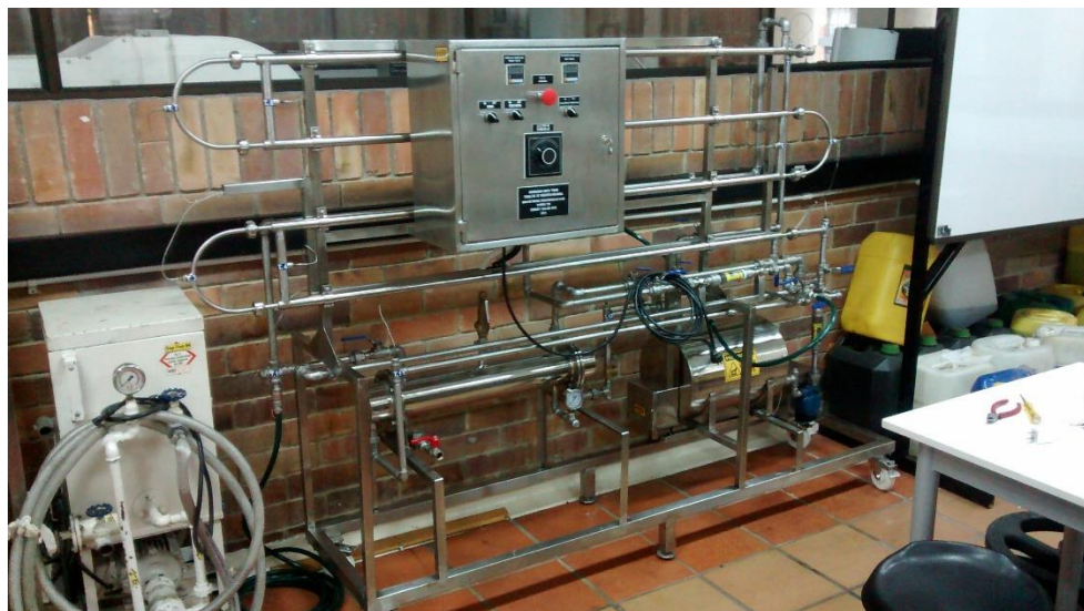
Figura 62 Banco de pruebas de transferencia de calor instalado en su sitio final. Fuente: Autor.
