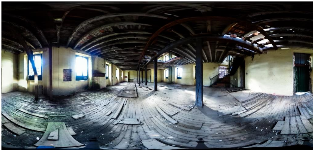
Fotografía No.5: Vista actual interior del Molino Tundama
