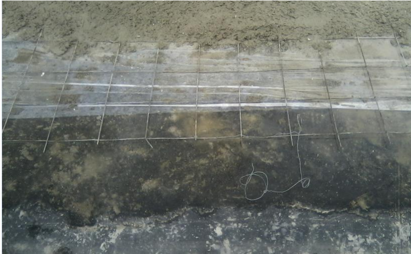
Imagen 25. Instalación de estructura de impermeabilización para placa de parqueaderos Urbanización Avatar
