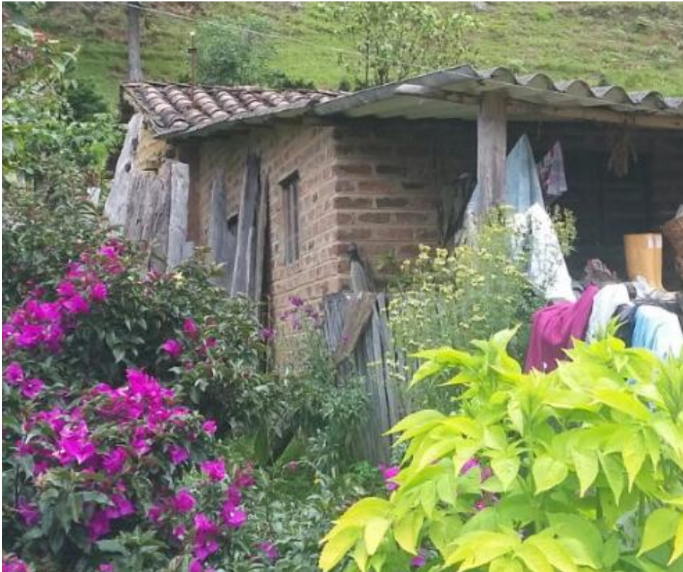
Imagen 13. Vivienda en Muros de Adobe con Proyección Frontal en Muro de Ladrillo
