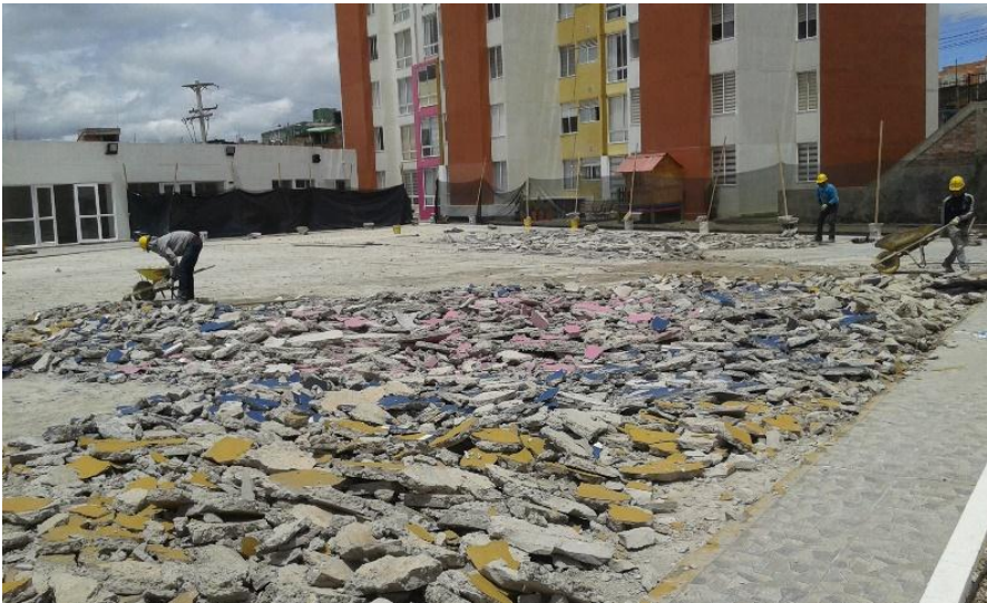
Imagen 20. Alistado de piso en estado de demolición y recolección de escombros Urbanización Avatar
