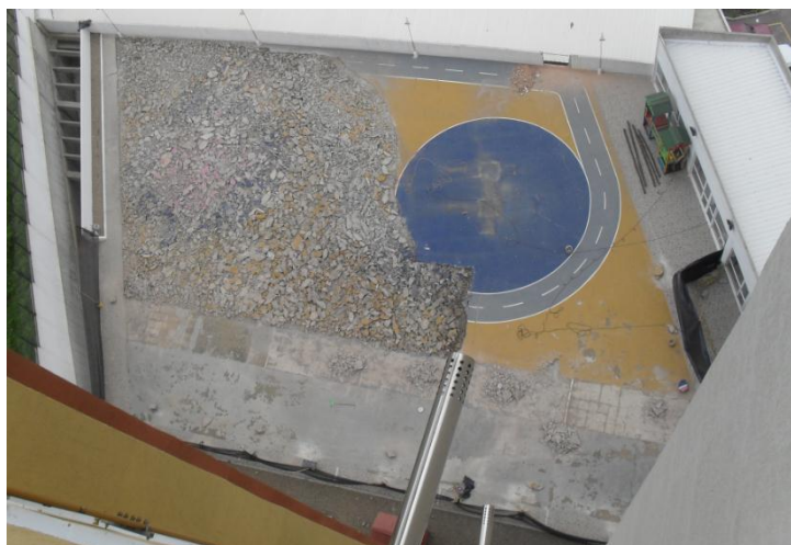
Imagen 32. Vista Aérea placa superior de parqueaderos y zona de recreación Urbanización Avatar
