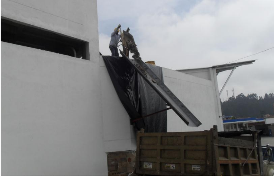
Imagen 21. Recolección de escombros resultado de demolición de alistado de piso Urbanización Avatar
