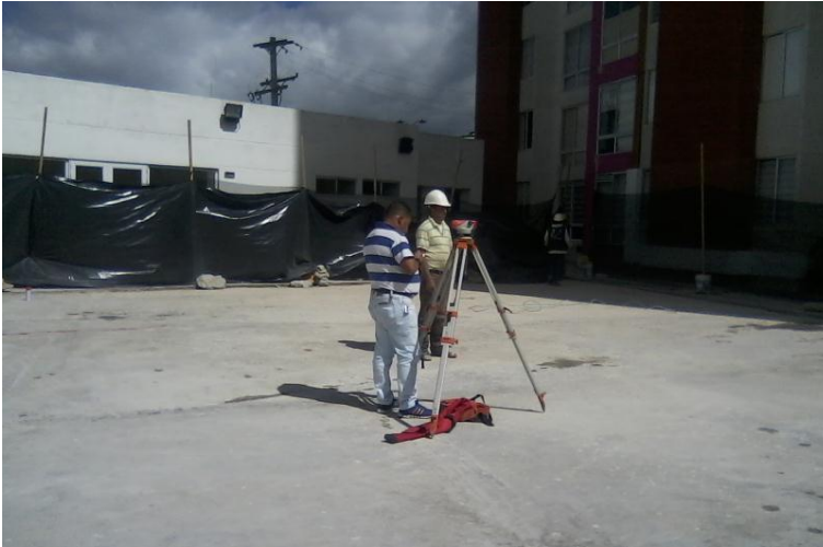
Imagen 23. Levantamiento topográfico en distintos puntos alrededor de placa de parqueaderos Urbanización Avatar
