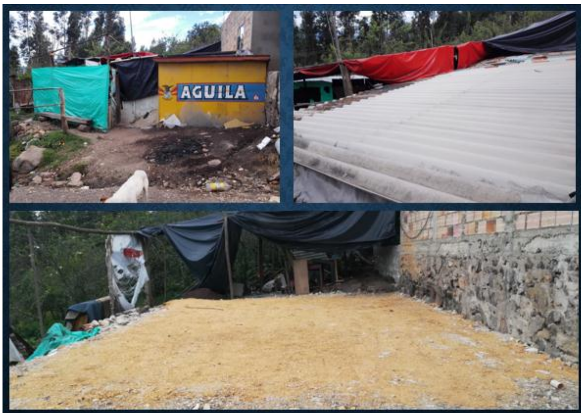
Imagen 14. Paso Transitorio de Construcción en Materiales Transitorios a Construcción de Vivienda en Sitio Propio
