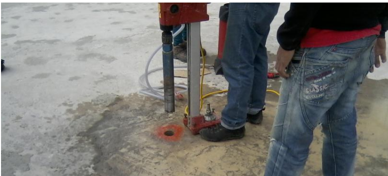
Imagen 24. Perforación placa de parqueaderos Urbanización Avatar
