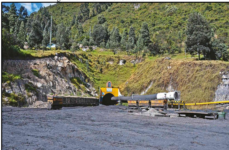
Figura 2. Mina "Túnel Casablanca".
