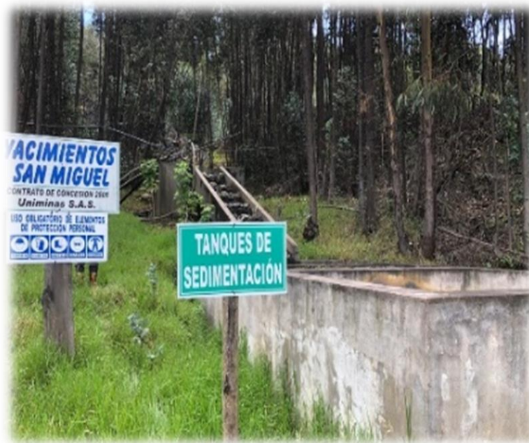
Figura 22. Tanque sedimentador Mina San Miguel.
