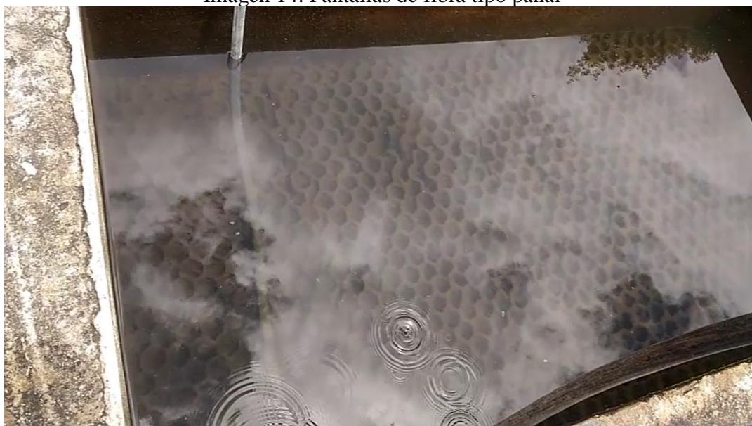
Imagen 14. Pantallas de fibra tipo panal
