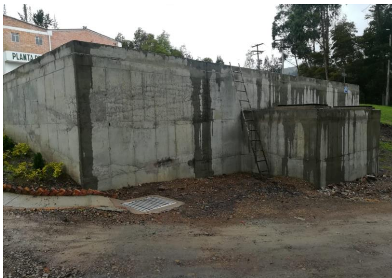
Imagen 28. Tanque distribución No.2
