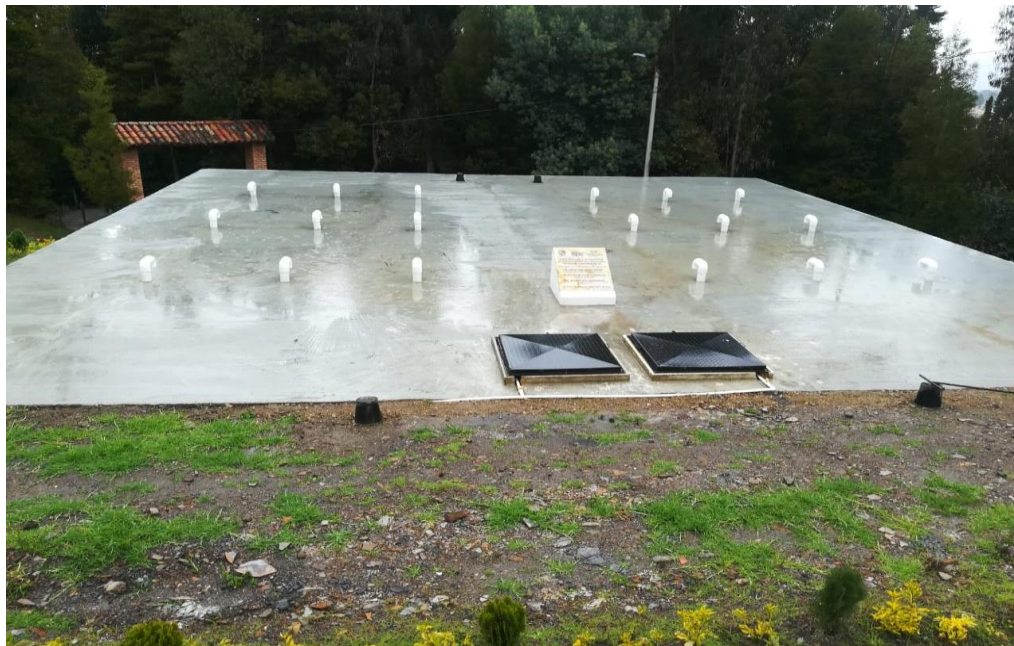
Imagen 29. Tanque distribución No.2
