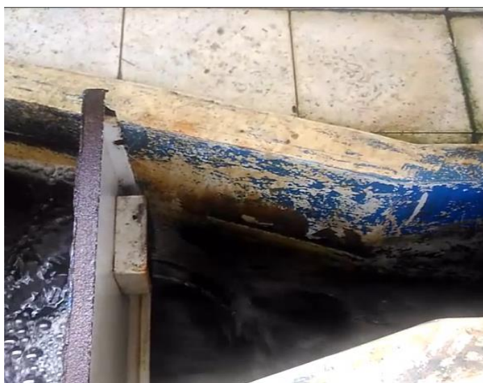
Imagen 7. Resalto hidráulico canaleta Parshall
