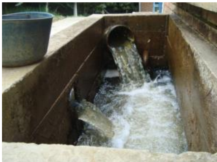
Imagen 5. Cámara de quietamiento
