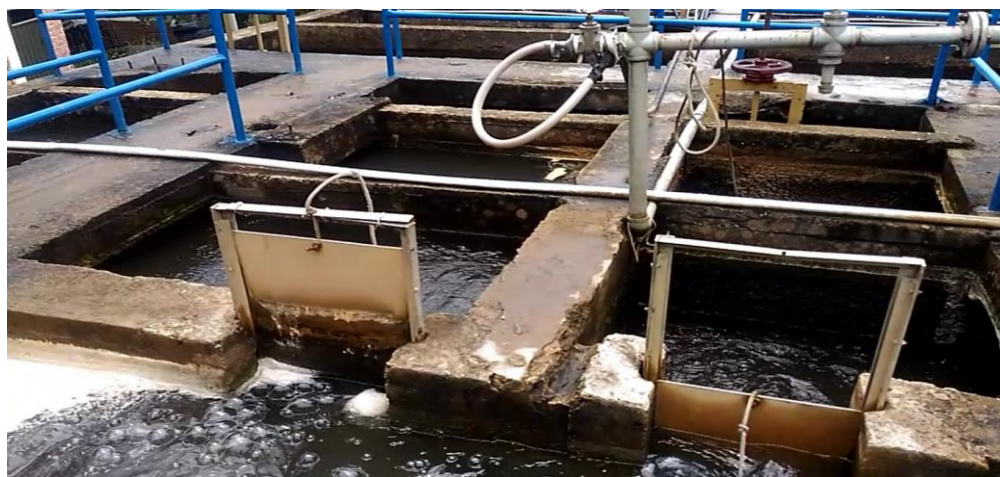
Imagen 12: Entrada a unidades de floculación
