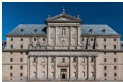
Figura 47. Fachada del monasterio de El Escorial. Bautista de Toledo, J. (s. XVI, arquitecto). Real Monasterio de San Lorenzo de El Escorial . El Escorial, Madrid
