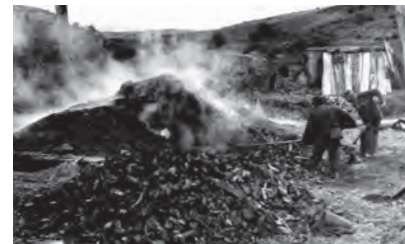
Aspecto general del horno y los trabajadores, para hacer carbón de madera de los pedazos que resultaran de la cortada y aserrada de los eucaliptos, donde los Paredes (Hacienda Tilatá). Junio 1950
