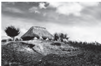
Casa de Inés de Lota (Saucio) Marzo 10/58 Albañilería 003 Albañilería
