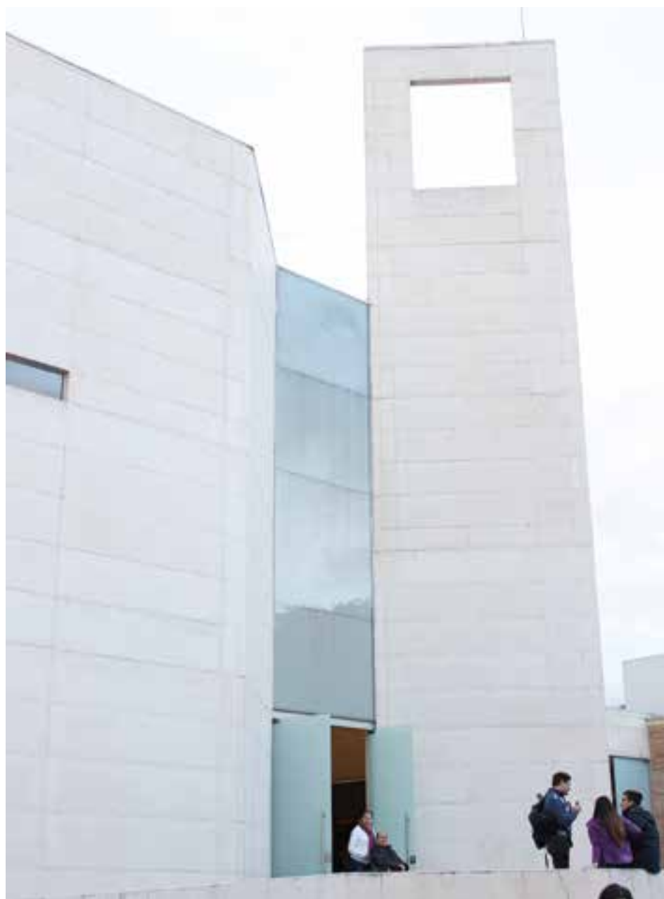
Figura 169. Acceso iglesia de San Norberto en Bogotá.
