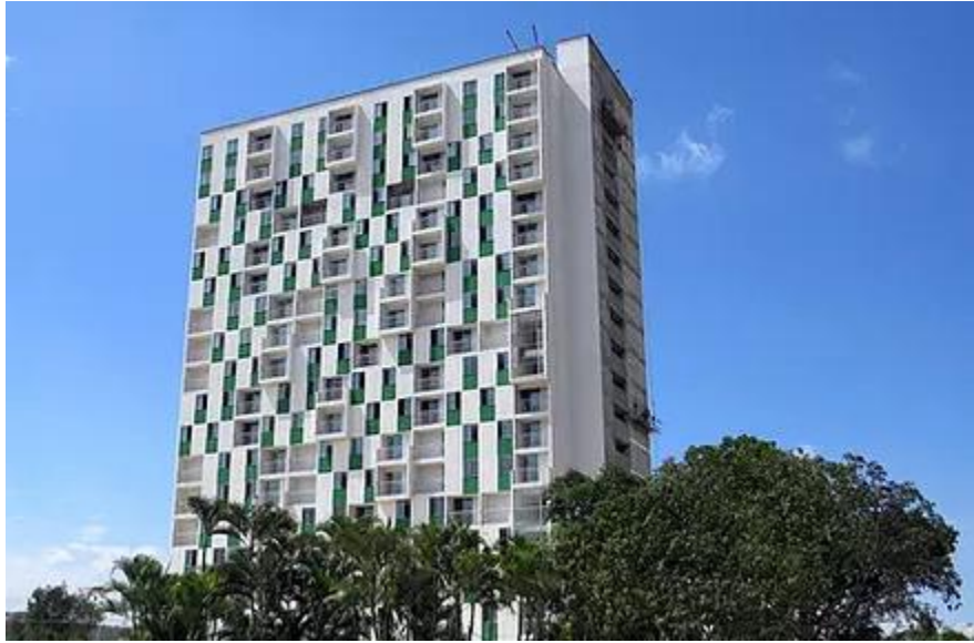
Figura 10. Vista lateral Torres veranda.
