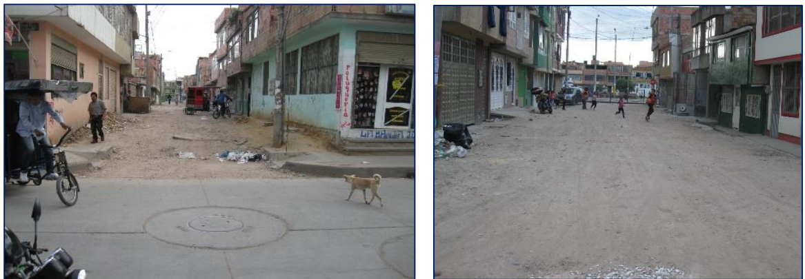
Ilustración 24. Estado de las vías aledañas a los jardines de la SDIS con mayor ausentismo escolar. Localidad de Kennedy.
