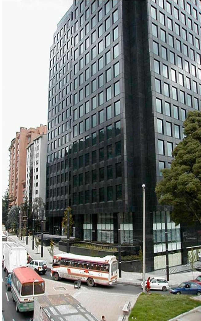
Figura 66. Perspectiva desde La Intersección Vial
