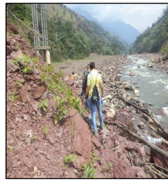
Figura 5. Deslizamientos margen derecho Río Guatiquía obstaculizando vía de acceso, por Castro. A & Díaz. L, 2018.
