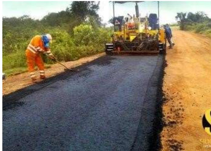
Nota: Aplicación de emulsión asfáltica en vía terciaria. Adaptado de (*SilicondpoX*, 2021)
