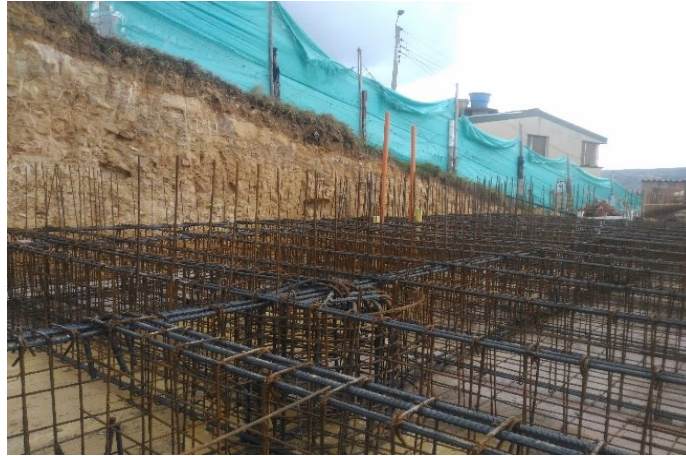
Ilustración 13. Arranques de Muros
