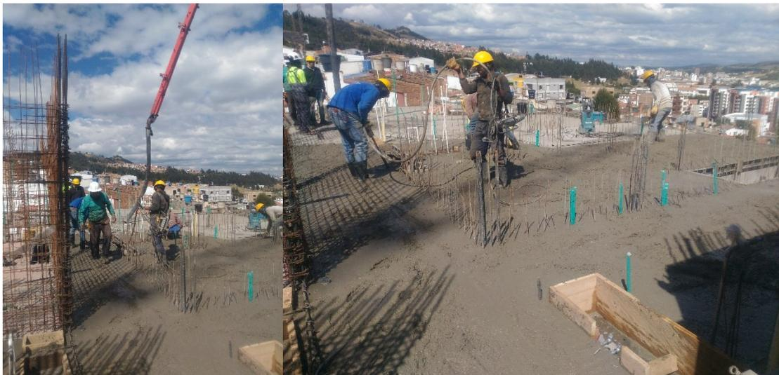
Se realiza control en la fundida de muros P4-V2; Y20, Y21, X27, X25, Y1, Y1A, X5, Y3, X7, X4, Y2 y X6. Se funden con concreto premezclado Holcim de 3000psi y se toman muestras para slump y cilindros en concreto.
