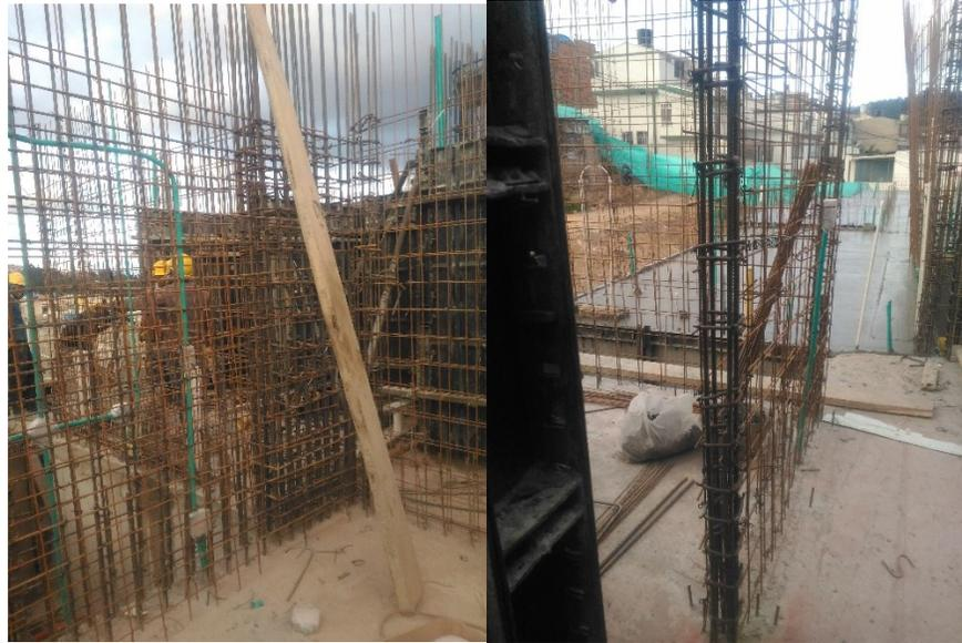
Se realizó control en la fundida de la placa del cuarto piso P4-V3, con concreto pre mezclado Holcim de 3000psi, así mismo se realizaron los ensayos de slump y toma de muestras para realizar los cilindros en concreto.
