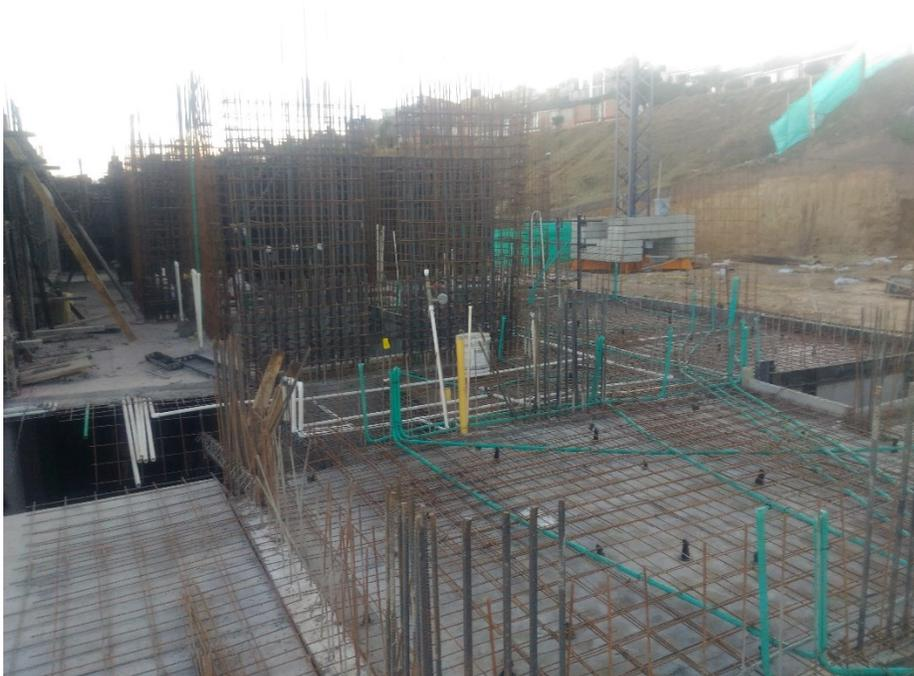
Se realiza control en la fundida de los muros P4-V1; X5, Y4, X2, Y5, X3, X8, X9, Y7, X11, Y10, Y9 y X18. Se fundieron con concreto premezclado de 3000psi, de igual manera se sacaron muestras para realizar los ensayos de asentamiento y cilindros en concreto, por último, se retira la formaleta de muros fundidos el día sábado.
