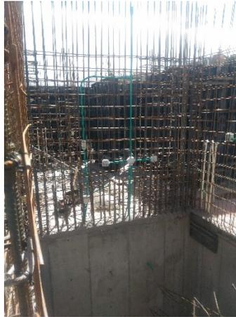
Se realiza control en la fundida de la placa P4-V4 la cual se termina de fundir con concreto pre mezclado Holcim de 3000psi; se toman las muestras para realizar ensayo del cono de Abraham y para cilindros en concreto. Esto se tuvo que realizar con bomba de concreto estacionaria por el inconveniente de la torre grúa.
