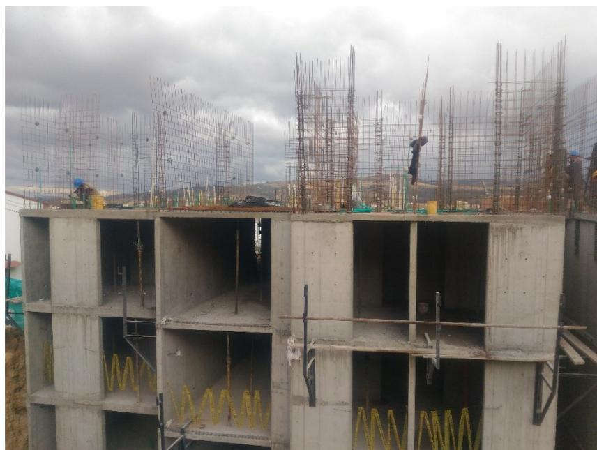
Se realiza el control en el amarrado de la malla electro soldada de 0,15x0,15m e instalación de tubería y accesorios de agua potable, agua caliente, gas y eléctrica que va embebida en la placa P4-V4, así como la instalación de la formaleta de la placa.
