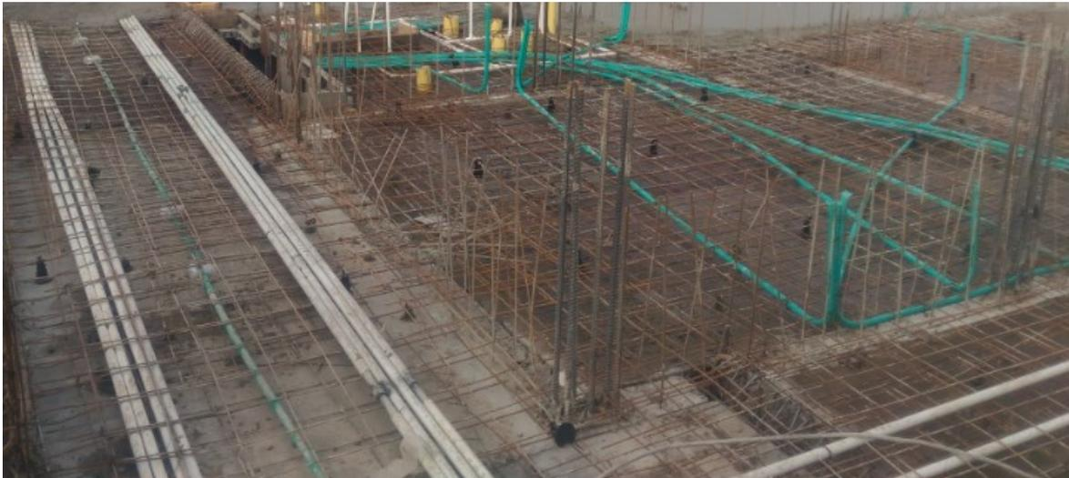
Se realiza control en la fundida de la placa P4-V4, fundida con concreto premezclado Holcim de 3000psi, se sacaron muestras de concreto para realizar el ensayo de asentamiento y cilindros en concreto. Se fundió la mitad de la placa ya que la torre grúa quedó fuera de servicio.
