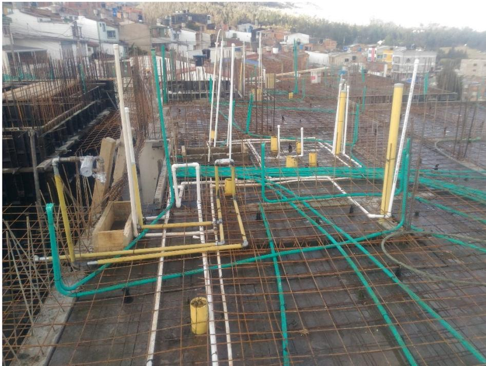
Se realiza control en la fundida de la placa P5-V1, se fundió con bomba estacionaria, concreto premezclado Holcim de 3000psi, se tomaron las muestras para ensayo de asentamiento y cilindros en concreto.
