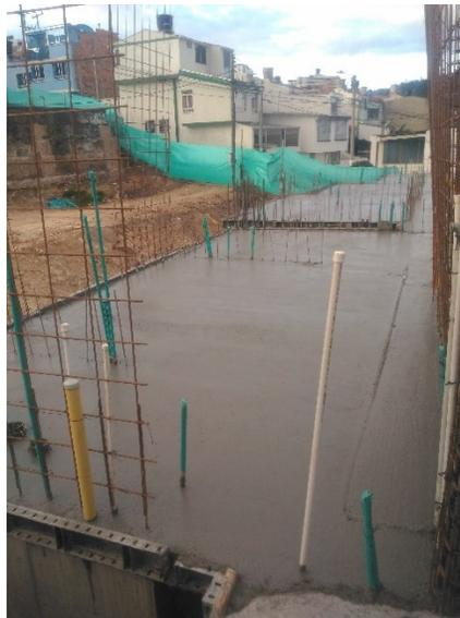
Se realiza control en la fundida P4-V1 que corresponde a los muros, X17, X13, Y16, Y18, Y17, Y19A, X19 y Y19; así mismo se realizó el ensayo de slump a cada una de las mixers que ingresaron, se fundió con concreto premezclado Holcim de 3000psi y por último se tomó la muestra para cilindros en concreto.
