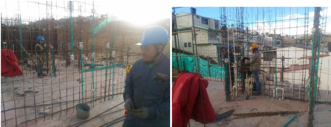
Se realiza control en el amarre de acero para la placa P5-V1; así como en la instalación de tubería y accesorios, agua potable, agua caliente, gas hg y eléctricas; que van embebidas en placa por último se colocan los distanciadores de malla para placa.
