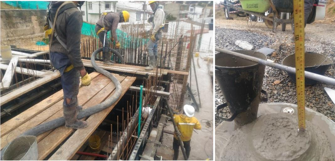
Se realiza control en la actividad de amarrado de acero para placa P5-V1 además de la instalación de tubería y accesorios, hidráulicos, gas y eléctricos.
