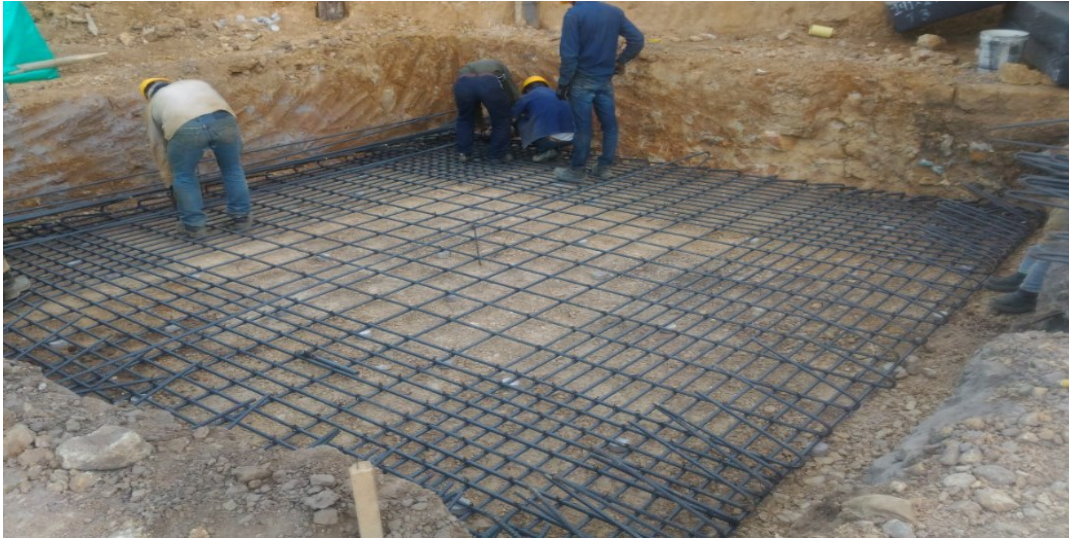
Amarrado de la parrilla destinada a la base de la torre grúa.
