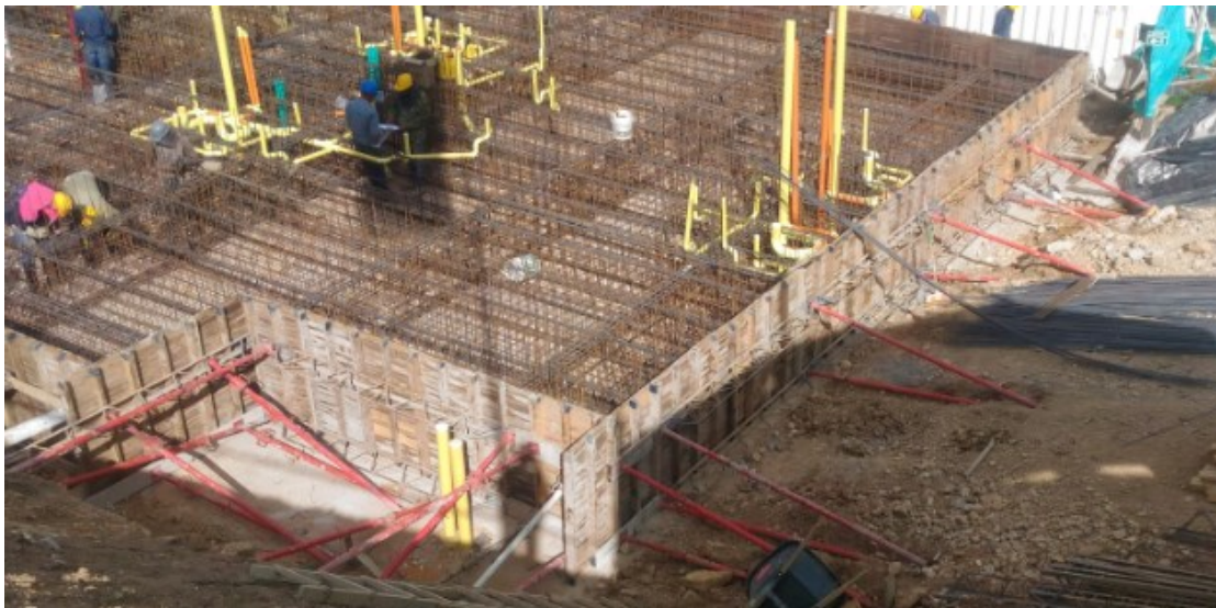
Instalación tuberías sanitaria y red contra incendios.
