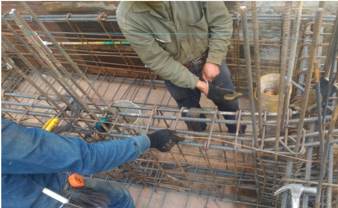
Amarrado de arranques de muros y doble parrilla.
