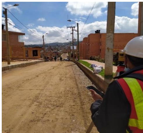
Fotografía 31. Chequeo de cotas en el terreno.
