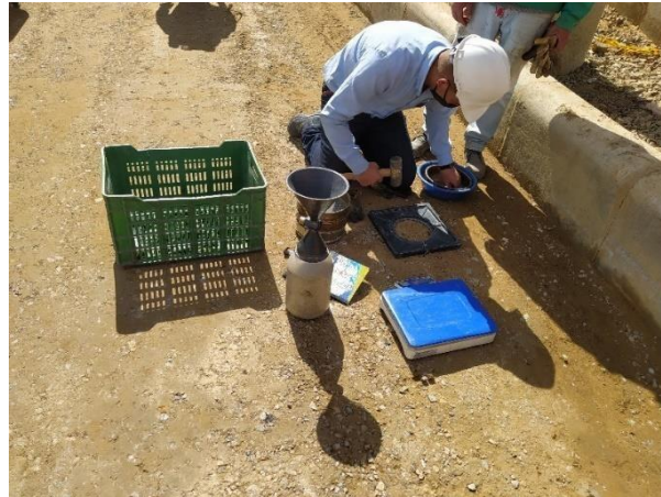
Fotografía 30. Ensayo de densidades para base.
