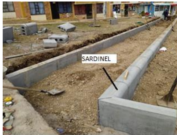
Fotografía 6. Instalación de sardineles
