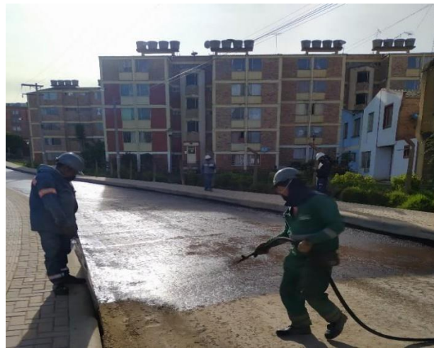
Fotografía 17. Imprimación de emulsión asfáltica.
