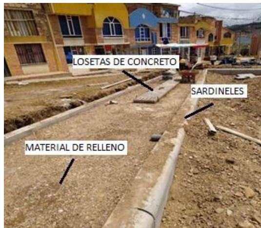
Fotografía 8. Relleno de afirmado y losetas de concreto.
