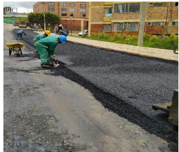
Fotografía 18. extensión de carpeta asfáltica. Fotografía 19. Enrasado de carpeta asfáltica
