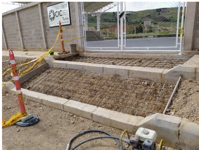
Fotografía 39. Acero de refuerzo para rampas.
