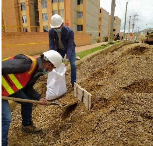
Fotografía 27. Recolección de muestras de material granular acopiado.
