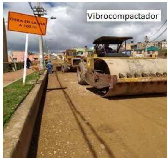
Fotografía 13. Compactación de capa granular subbase.
