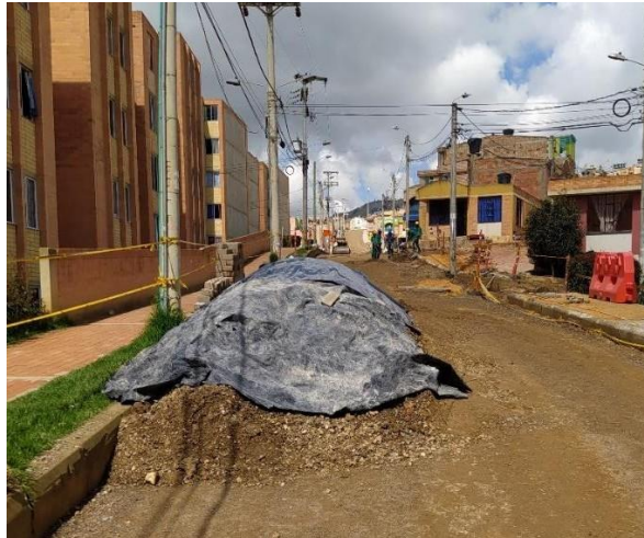
Fotografía 15. Acopio de material.
