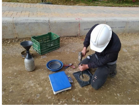
Fotografía 29. Ensayo de densidades para subbase.
