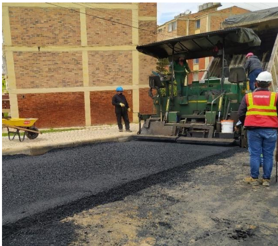
Fotografía 18. extensión de carpeta asfáltica. Fotografía 19. Enrasado de carpeta asfáltica
