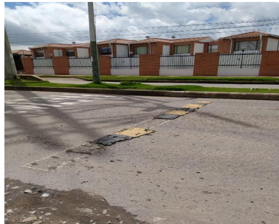
Fotografía 49. resalto portátil con desgaste.
