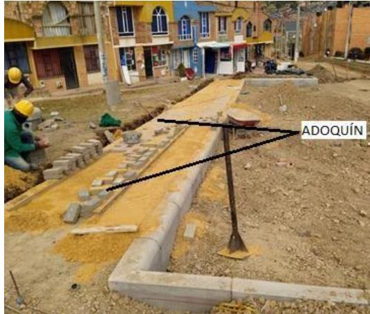
Fotografía 9. Instalación de adoquín y compactación de arena.
