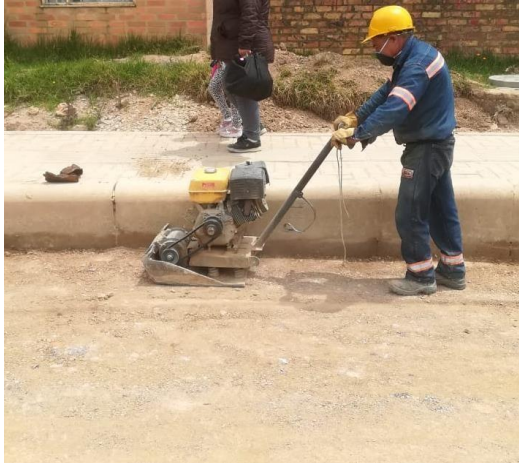
Fotografía 14. Compactación con plancha vibradora.
