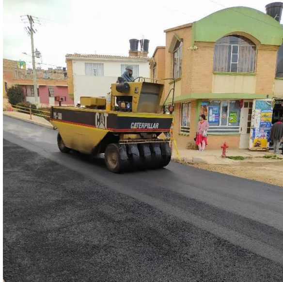
Fotografía 21. Compactación con rodillos.
