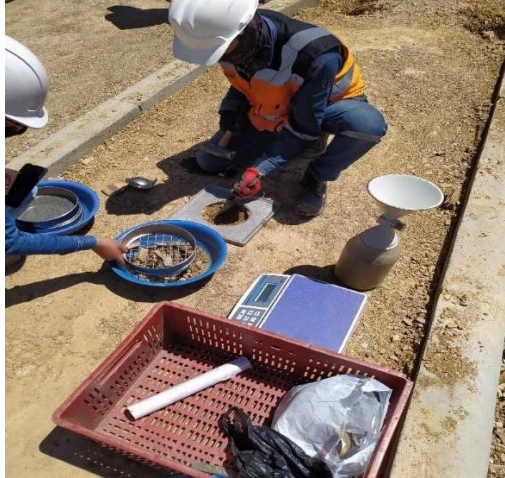
Fotografía 7. Ensayo de densidades para afirmado.
