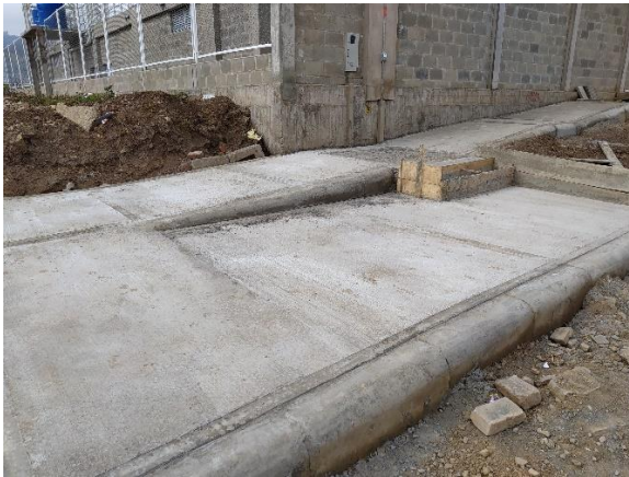
Fotografía 35. Rampas de acceso peatonal.
