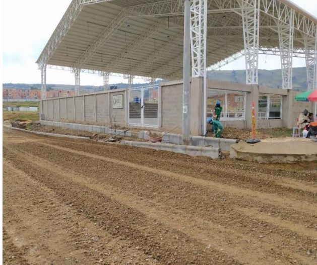
Fotografía 3. Vía en construcción, Tramo 3, La Florida.
