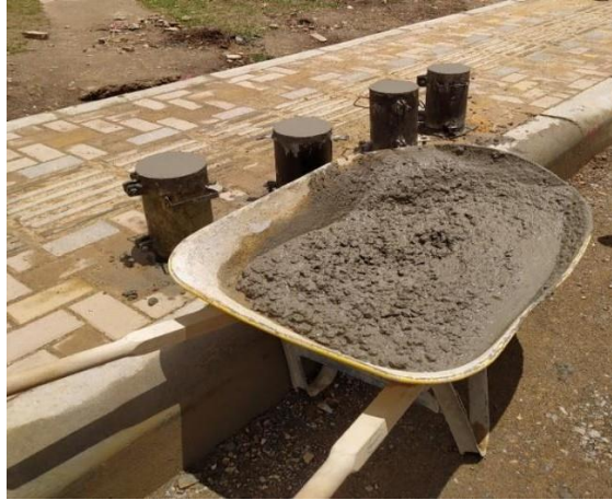
Fotografía 34. Cilindros de concreto.
