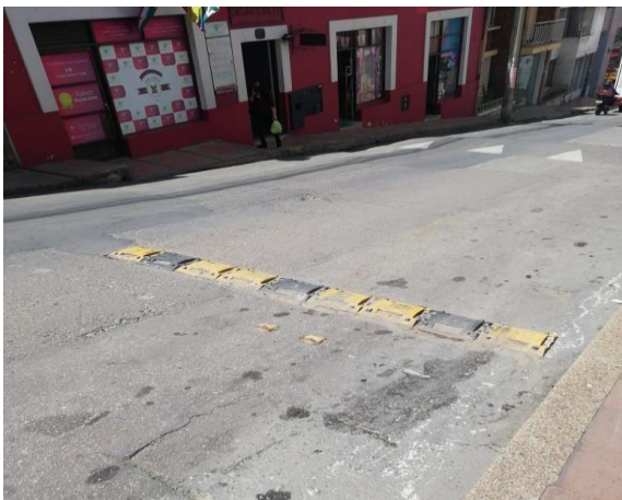
Fotografía 49. resalto portátil con desgaste.
