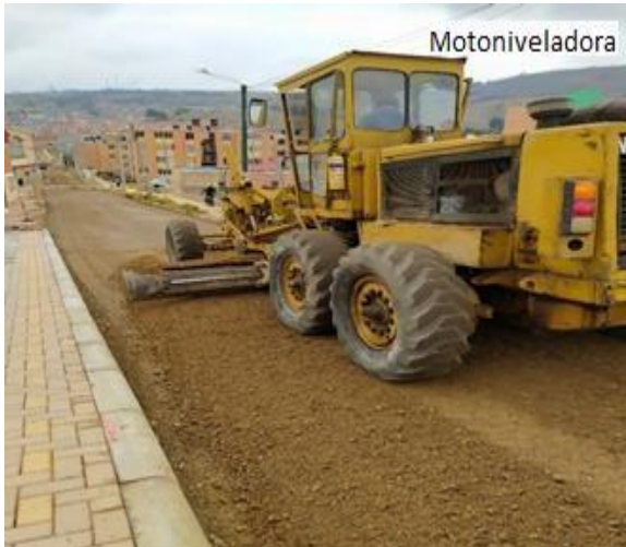
Fotografía 11. Extensión de material subbase.
