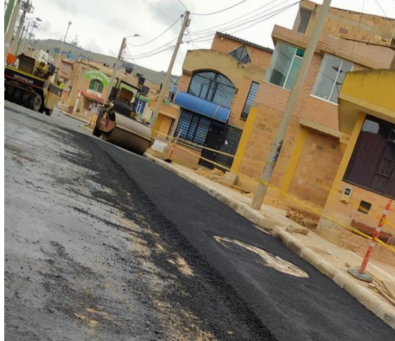
Fotografía 20. Compactación carpeta asfáltica
