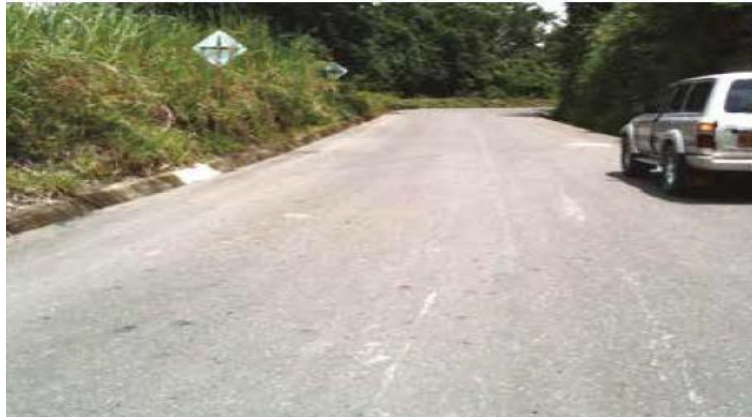
Figura 2. Vía con capa superficial en material de arena-asfalto natural de la mina Isaza (2011)
