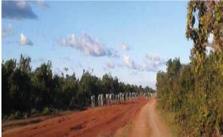
Figura 9. Vía construida con material tipo laterítico en el Departamento del Vichada.
