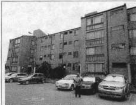
Fotografía 5. Vista de fachada oriental del bloque 4, evidencia daños leves.
