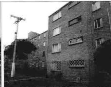
Fotografía 2. Vista de fachada sur del bloque 15, no evidencia daños.
