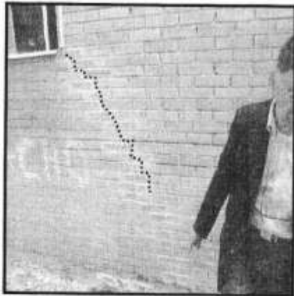
Fotografías 13 y 14. Fisuras en la fachada sur, de tendencia escalonada en el primer nivel del bloque 8, del Conjunto Residencial Agrupación de vivienda Pio XII.
