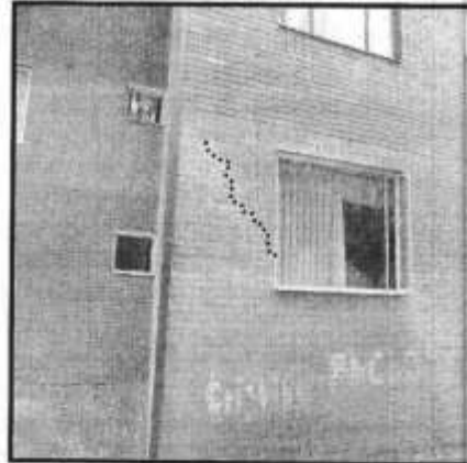
Fotografías 13 y 14. Fisuras en la fachada sur, de tendencia escalonada en el primer nivel del bloque 8, del Conjunto Residencial Agrupación de vivienda Pio XII.
