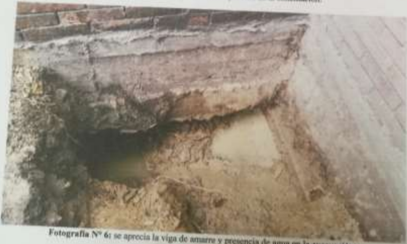
Fotografía N° 5: Apique para la inspección de la cimentación.
