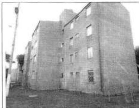
Fotografía 1. Vista de fachada norte del bloque 14, no evidencia daños.
