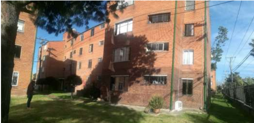
Fachada principal bloque N°8
