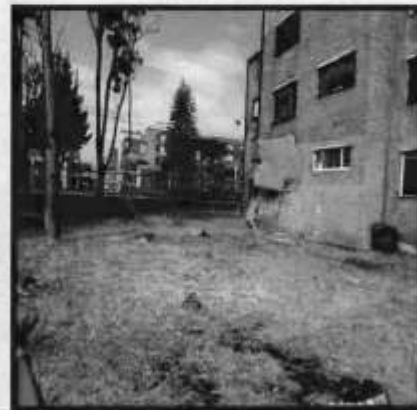
Fotografía 3. Árboles talados junto al bloque 8 en la visita del 9 de Marzo 2017
