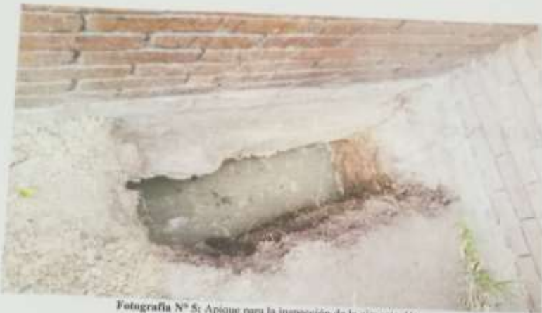
Fotografía N° 5: Apique para la inspección de la cimentación.
