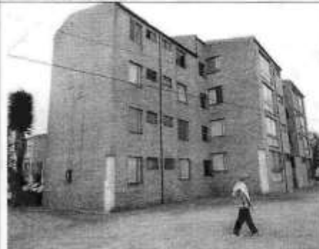
Fotografía 14. Vista de fachada norte del bloque 2, evidencia daños moderados.
