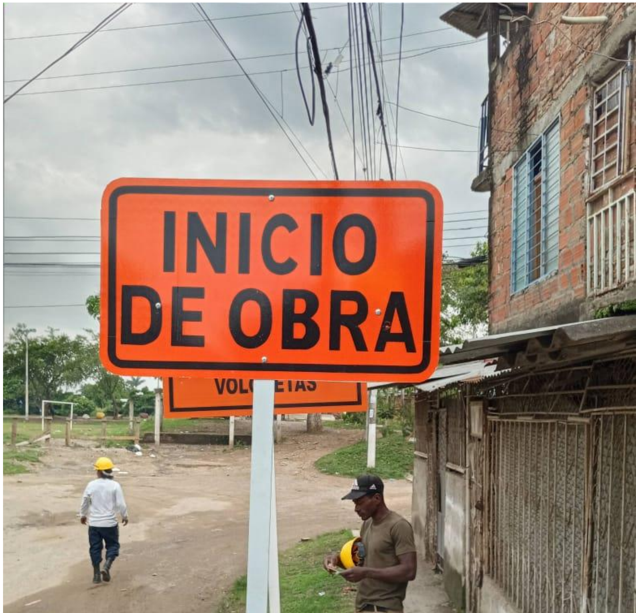
Figura 12. Señalización Inicio de obra sector Villa Blanca.
