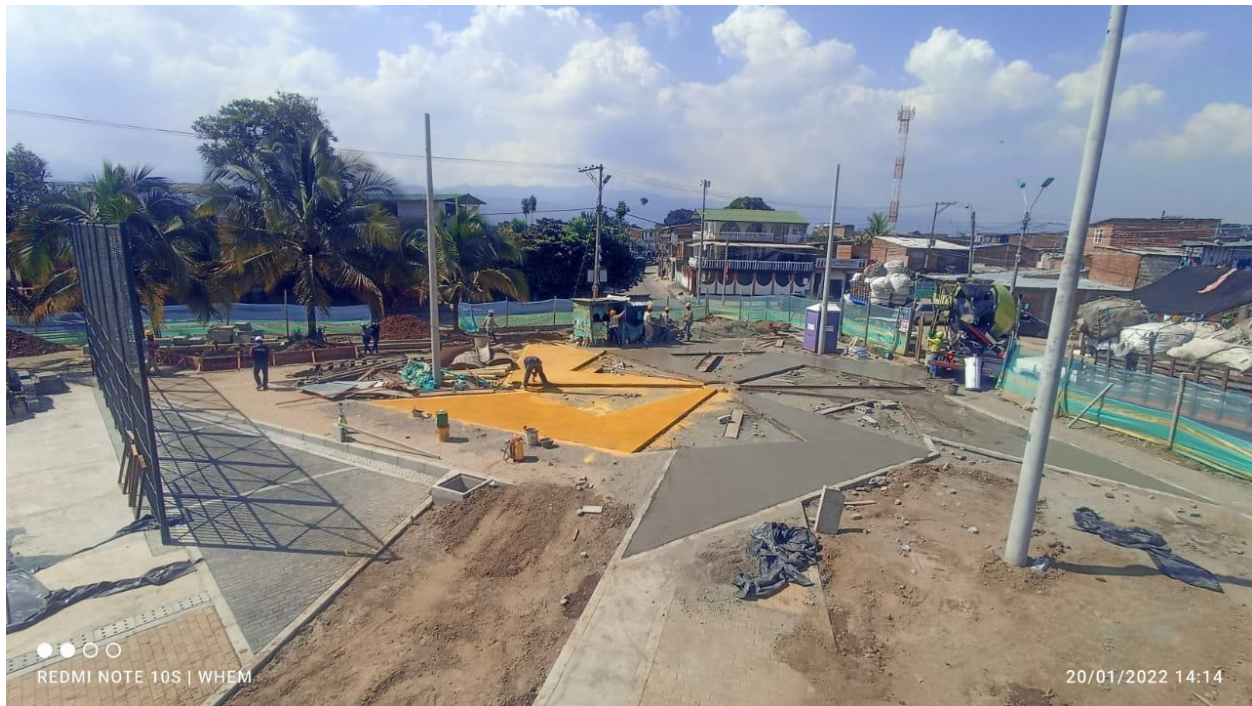
Figura 8. Proceso constructivo losa en concreto para andenes y/o zonas de concreto estampado.
