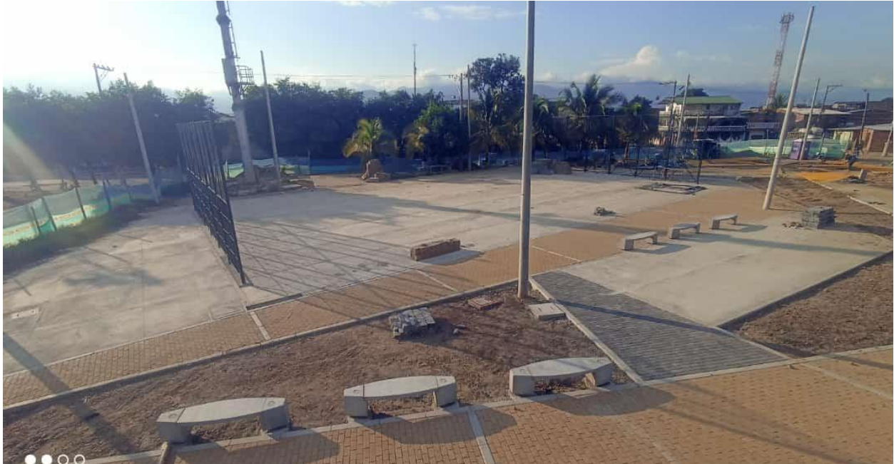
Figura 7. Sellado de juntas y relleno Parque Charco Azul.
