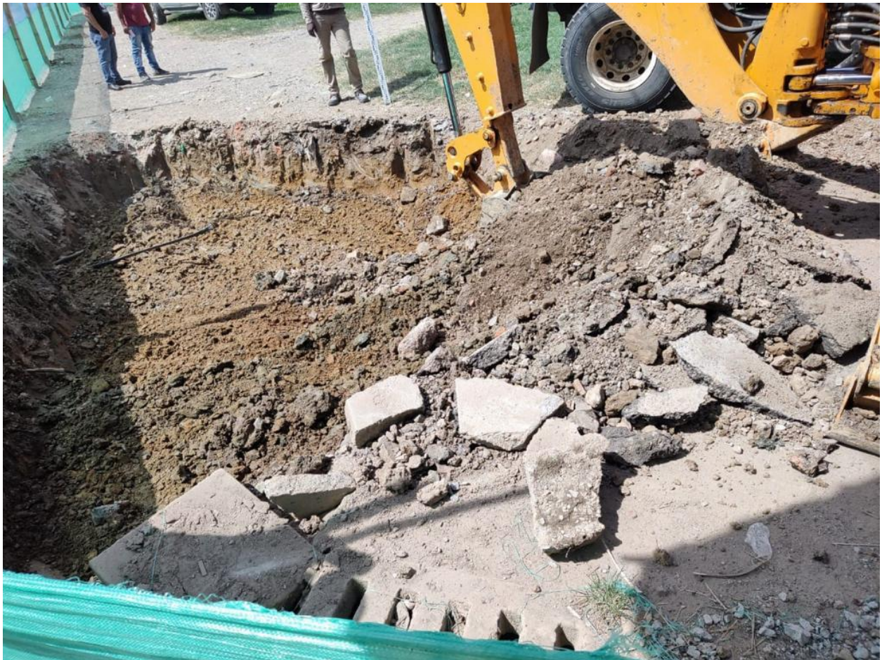
Figura 13. Demolición mecánica losas de concreto sector Villa Blanca.
