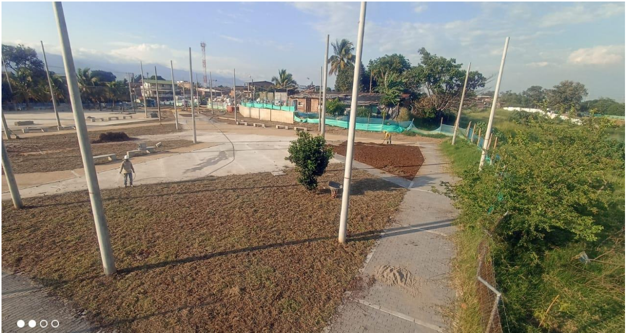
Figura 6. Nivelación, compactación, descapote y corte Parque Charco Azul.
