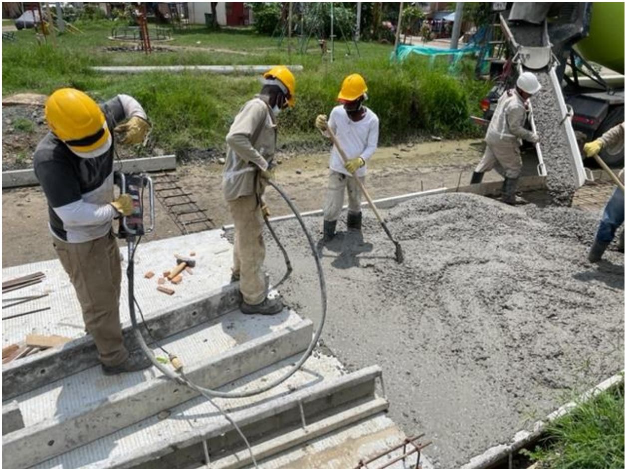
Figura 9. Proceso constructivo vaciado en in situ sector Rodrigo Lara
