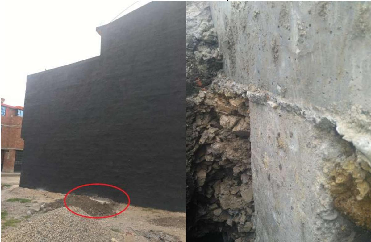
En dicho apique se evidencia que la cimentación existente corresponde a zapatas en concreto unidas entre si con vigas de cimentación en concreto con las siguientes dimensiones
