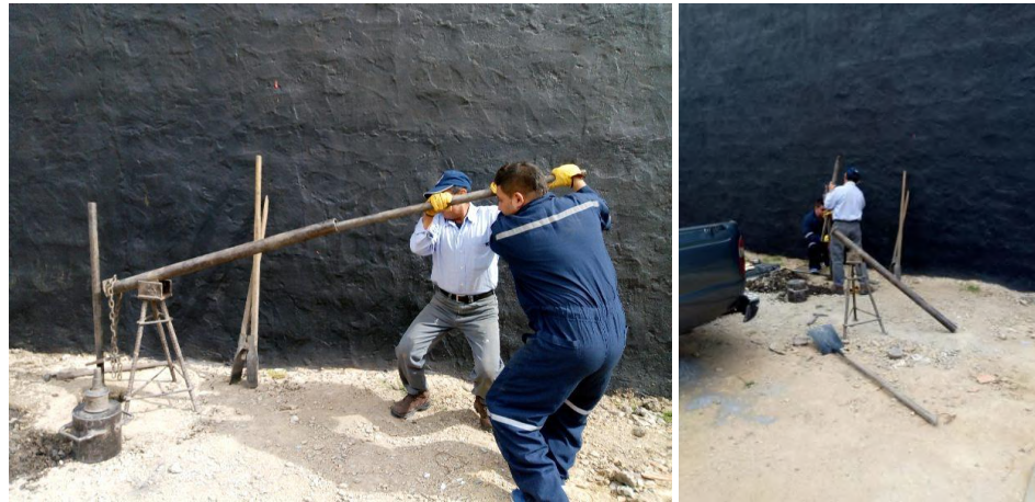
Fotografía 1. Localización del barreo manual de 6.00m de profundidad
