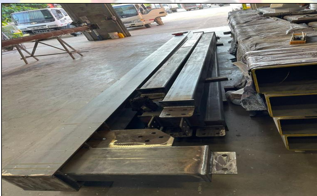
FIGURA 6. Supervisión de columnas
