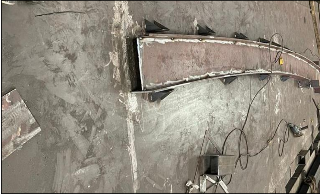
FIGURA 3. Supervisión del armado del alma de la cercha con sus respectivos patines
