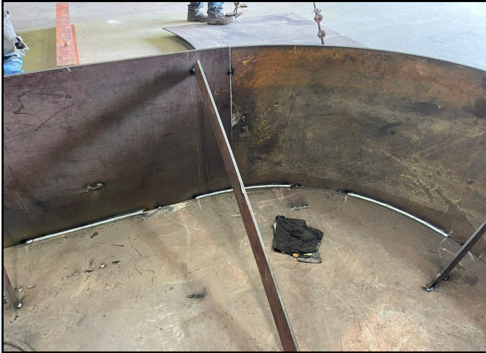
FIGURA 24. Supervisión de soldadura
