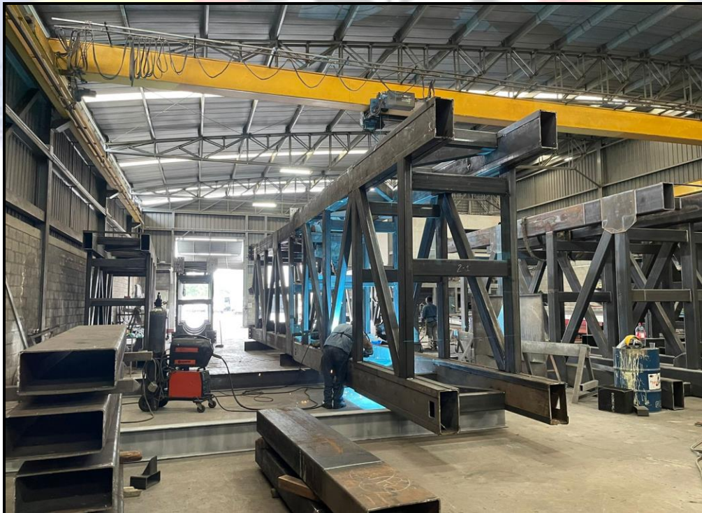
FIGURA 37. Inspección de resoldada de tubería
