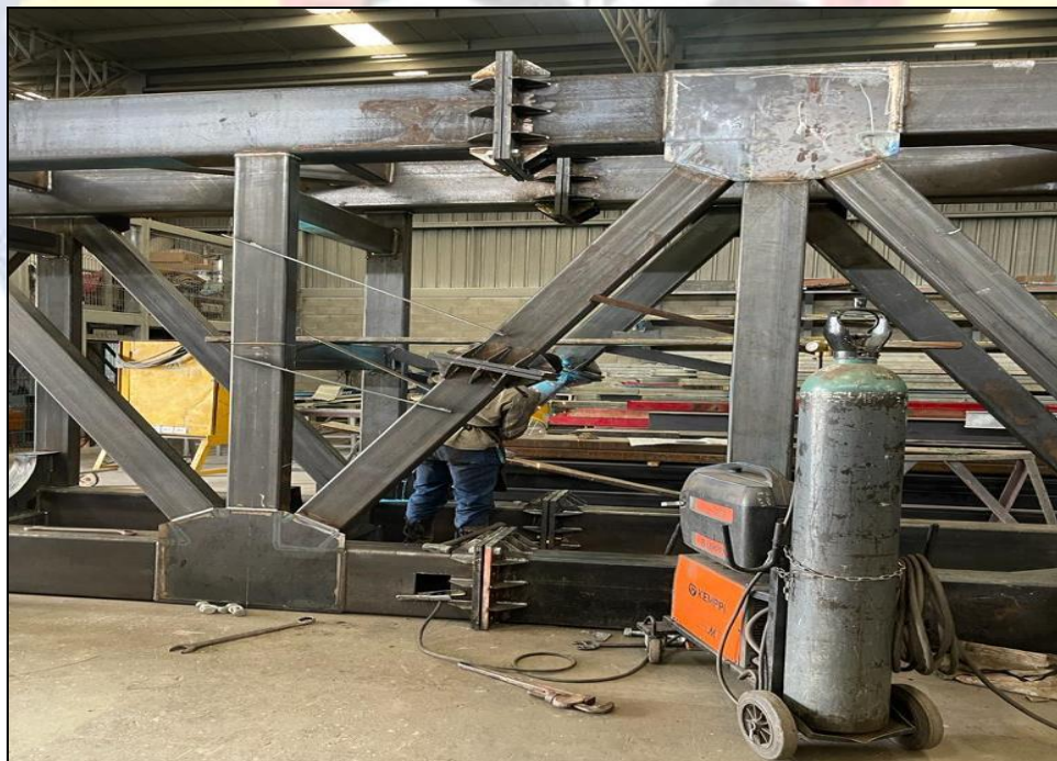
FIGURA 15. Supervisión de unión entre secciones
