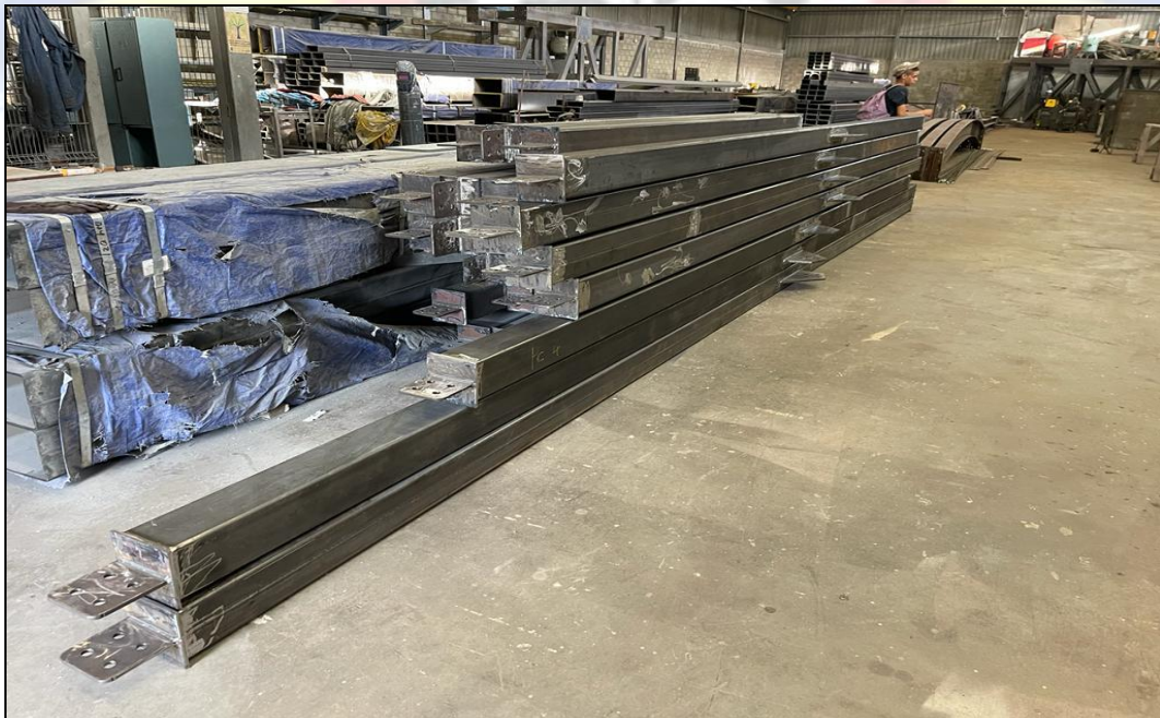
FIGURA 4. Supervisión de riostras
