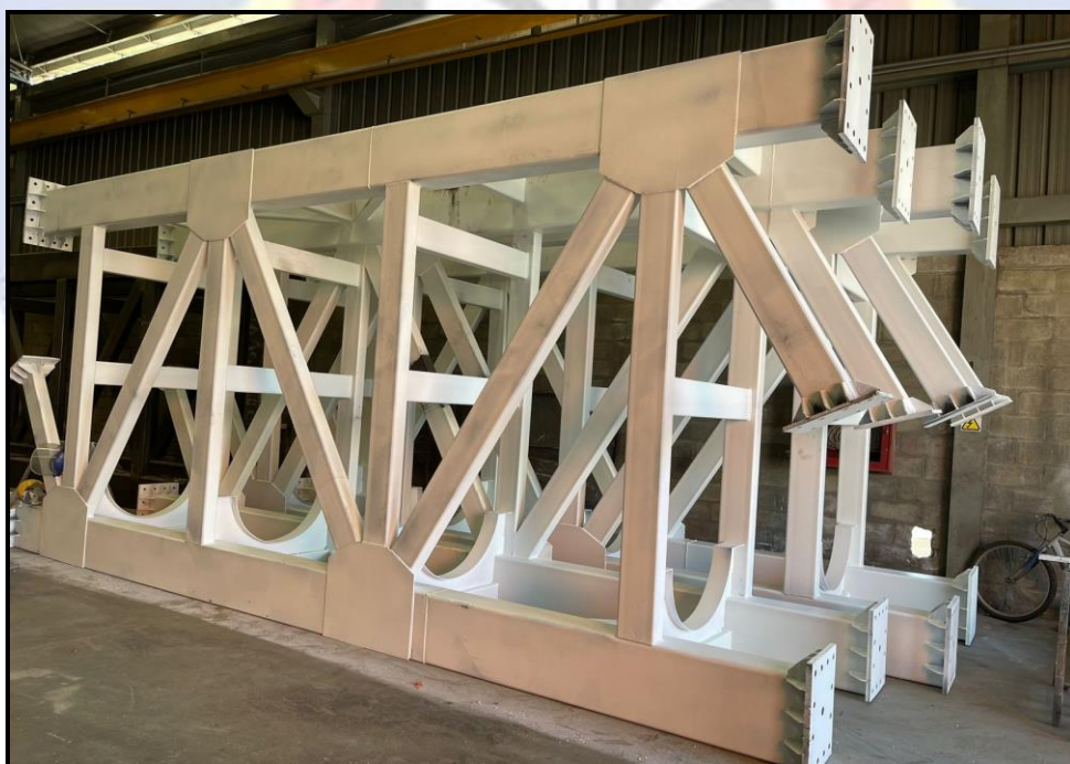
FIGURA 39. Supervisión de armado final de secciones con anticorrosivo
