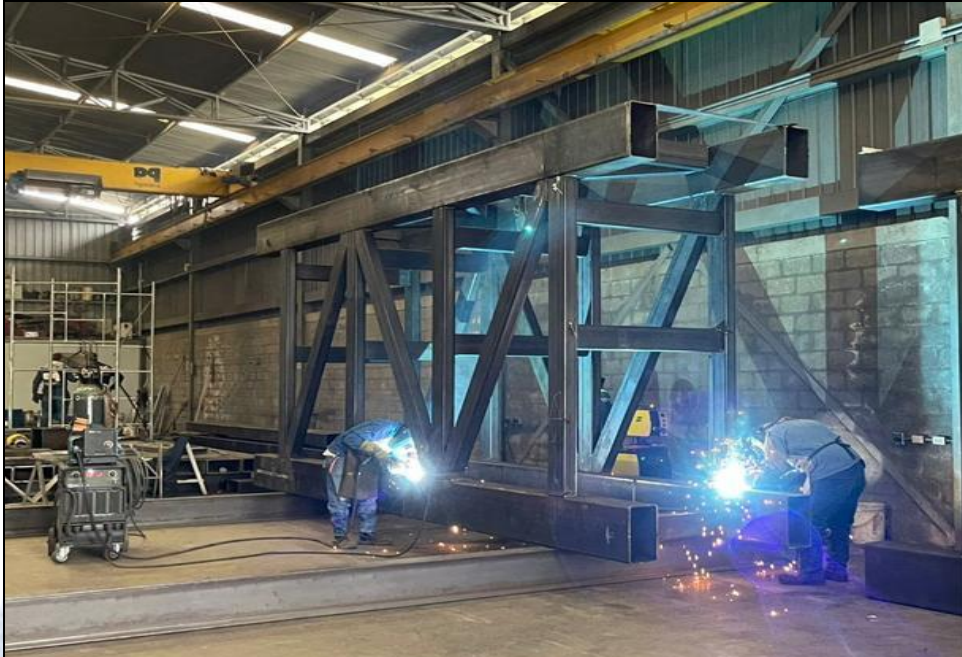
FIGURA 14. Inspección de soldada de secciones
