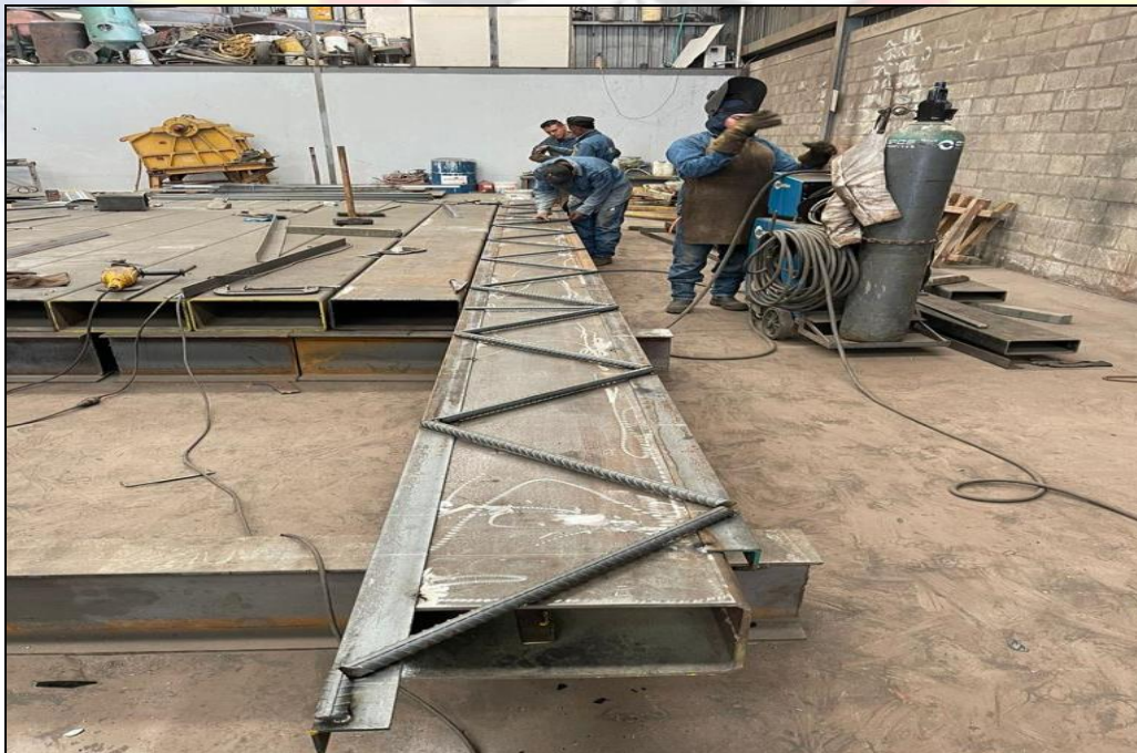
FIGURA 19. Supervisión de armado de joist
