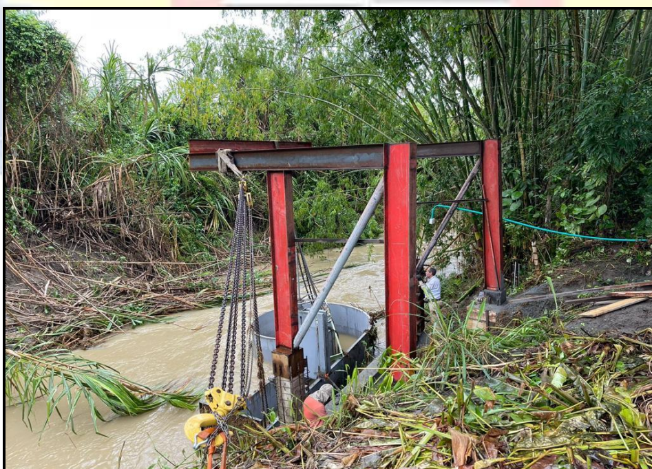
FIGURA 31. Supervisión de montaje
