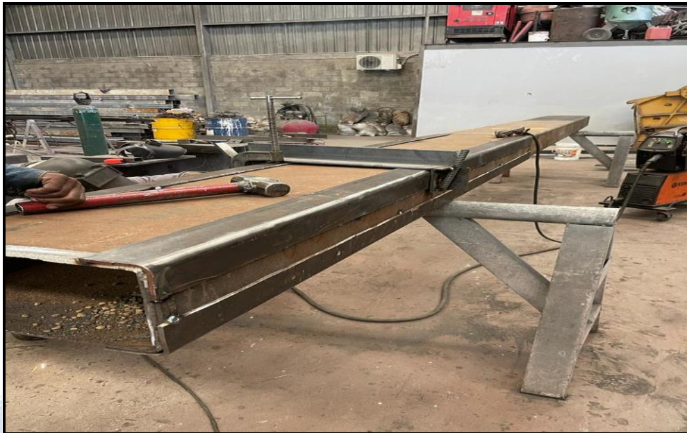
FIGURA 34. Supervisión de empalme de refuerzo con ángulos de 3"x1/4 para las secciones 1-2
