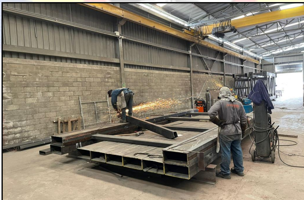
FIGURA 35. Supervisión de armado de secciones
