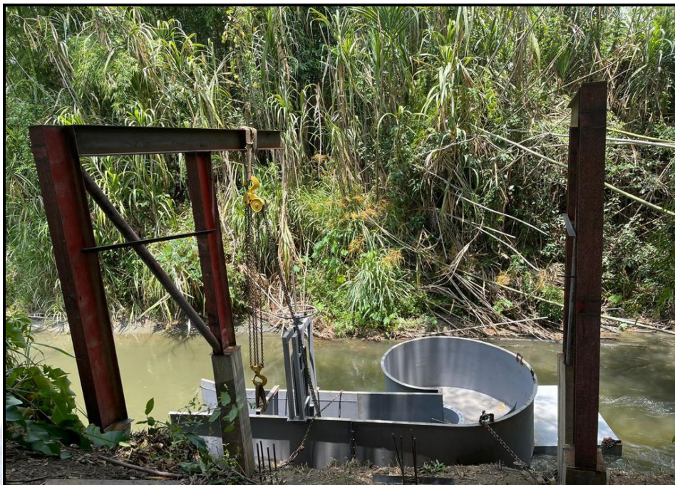
FIGURA 30. Supervisión de montaje
