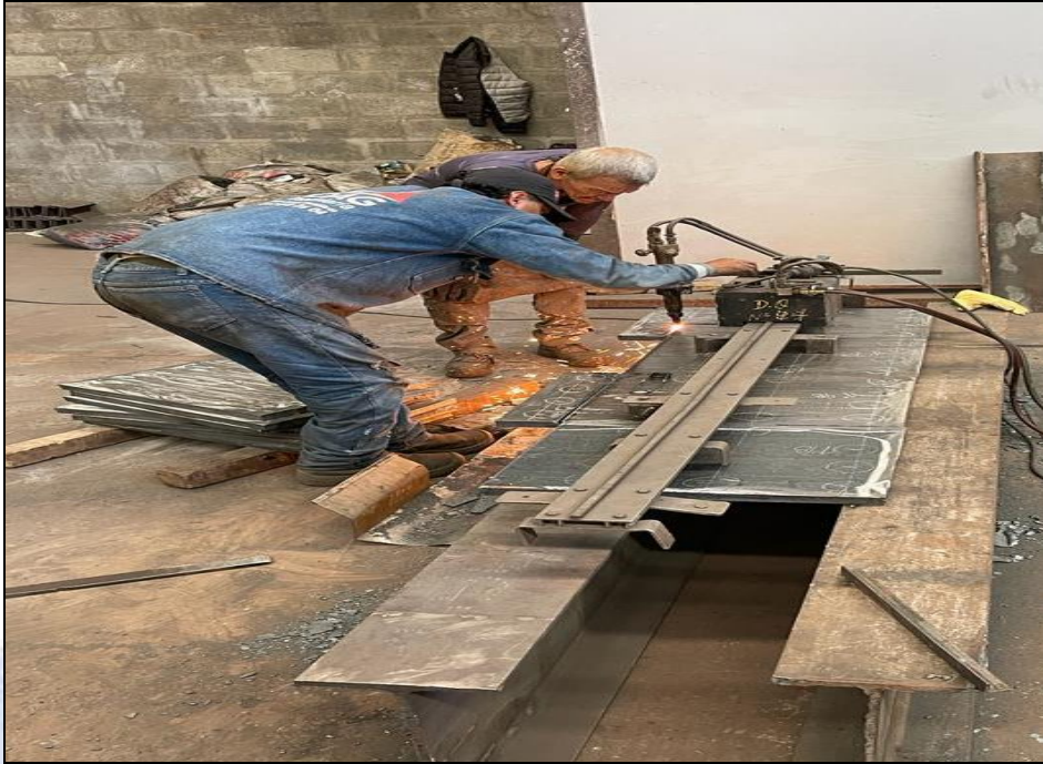
FIGURA 12. Supervisión de corte de end plate con tortuga
