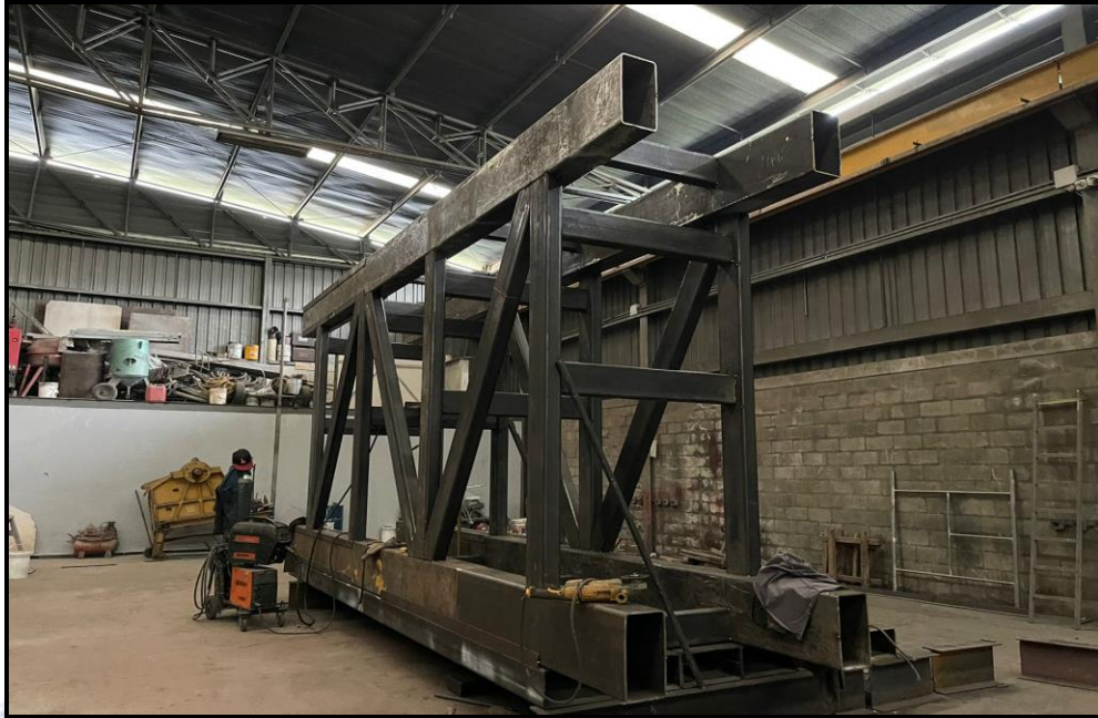
FIGURA 36. Supervisión de armado final de tubería
