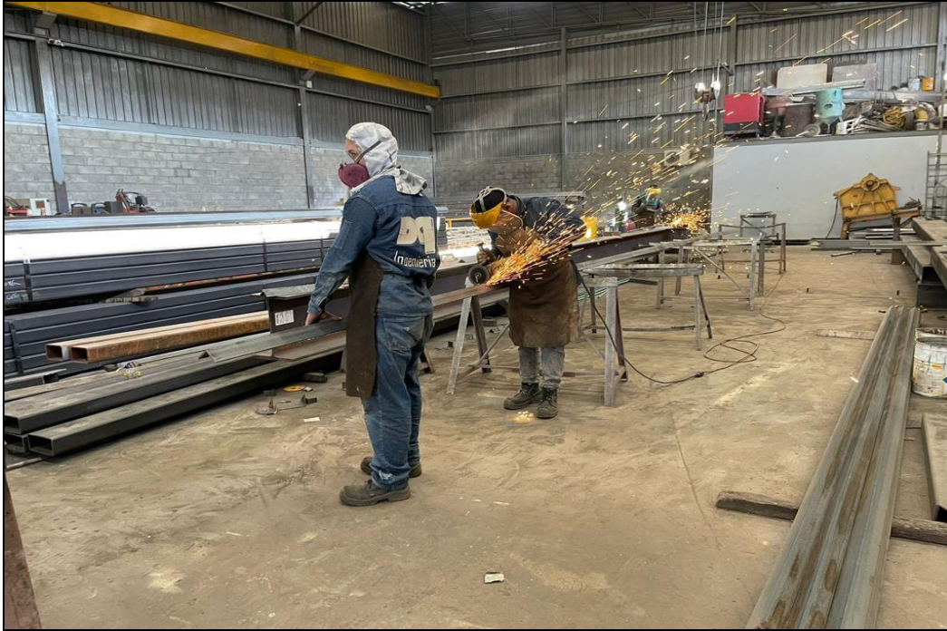
FIGURA 18. Supervisión de corte de ángulo con pulidora
