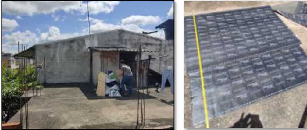
Figura 9. Cubierta en donde se implementó el proyecto
