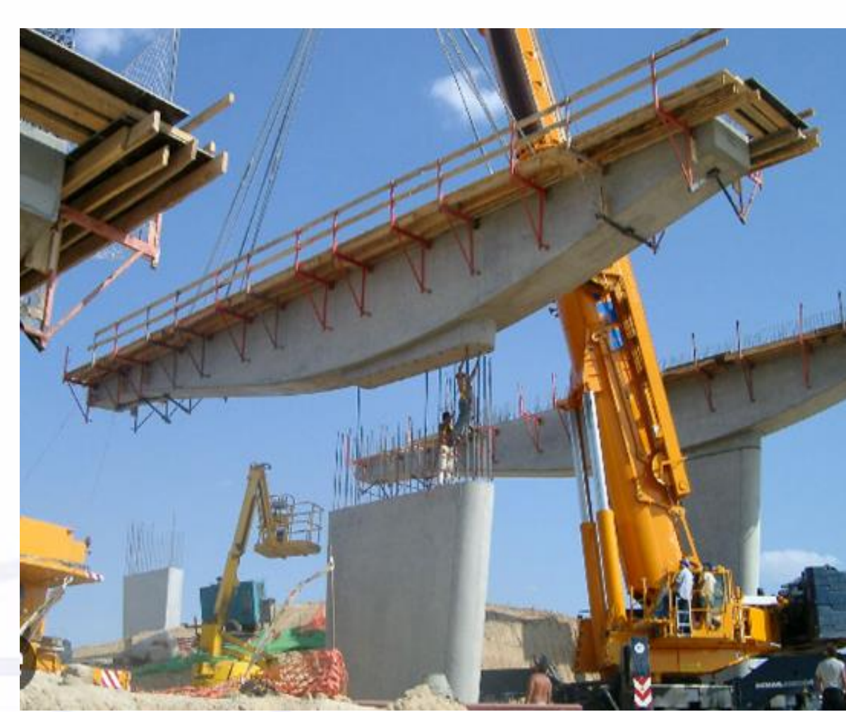
Secciones de Tablero
