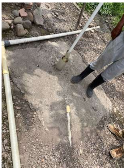
Figura 19 Pozo séptico con recubrimiento de cemento
