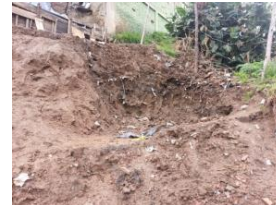
Constitución del talud. Fuente: Constructor.
