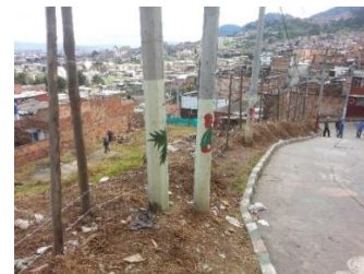
Vista del lote, de la vía y del talud de la CARRERA 10C ESTE. Fuente: Constructor.
