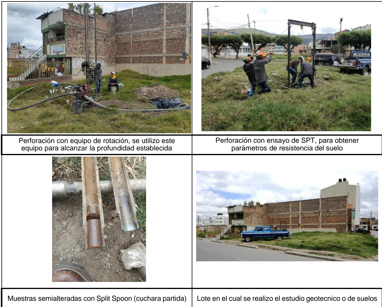
Ilustración 3: Registro fotográfico estudio geotécnico o de suelos.
