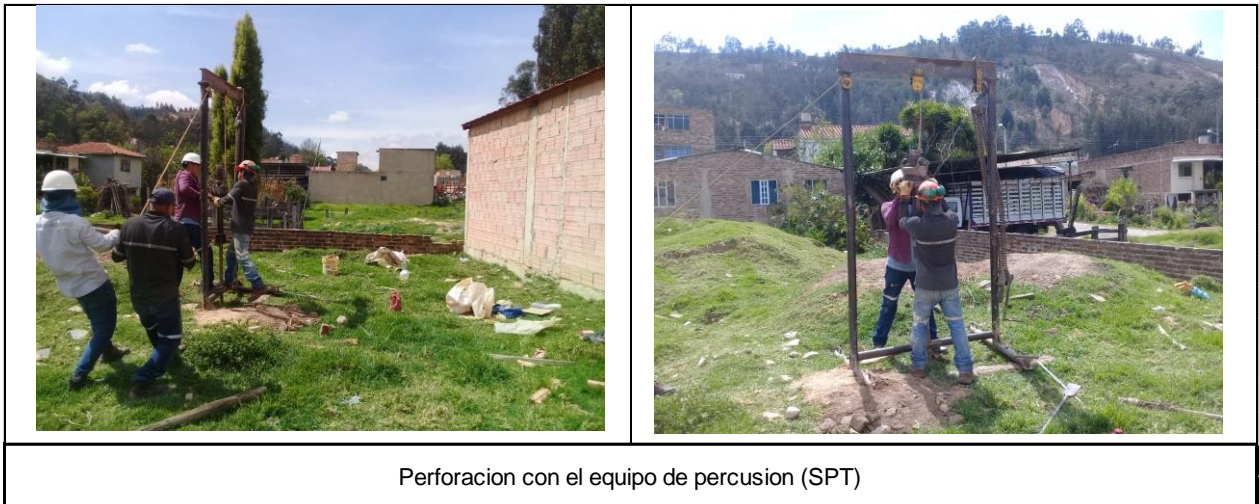
Ilustración 21: Registro fotográfico estudio geotécnico o de suelos.
