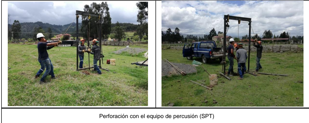
Ilustración 7: Registró fotográfico estudio geotécnico o de suelos.
