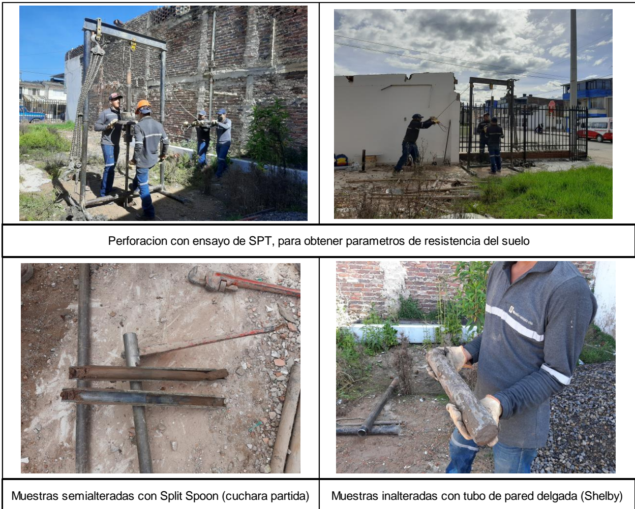
Ilustración 19: Registró fotográfico estudio geotécnico o de suelos.
