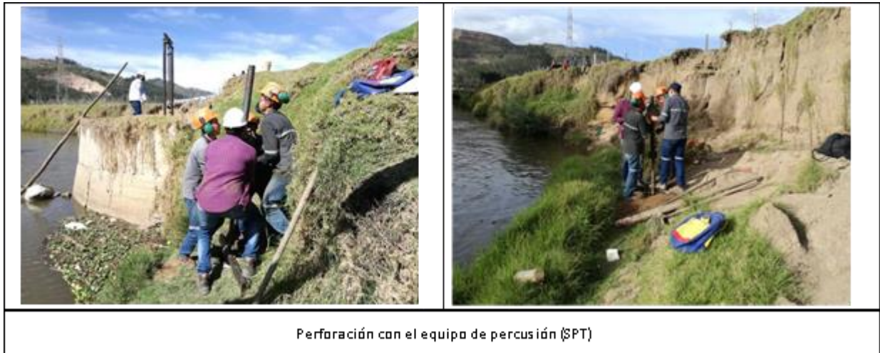
Ilustración 9: Registró fotográfico estudio geotécnico o de suelos.
