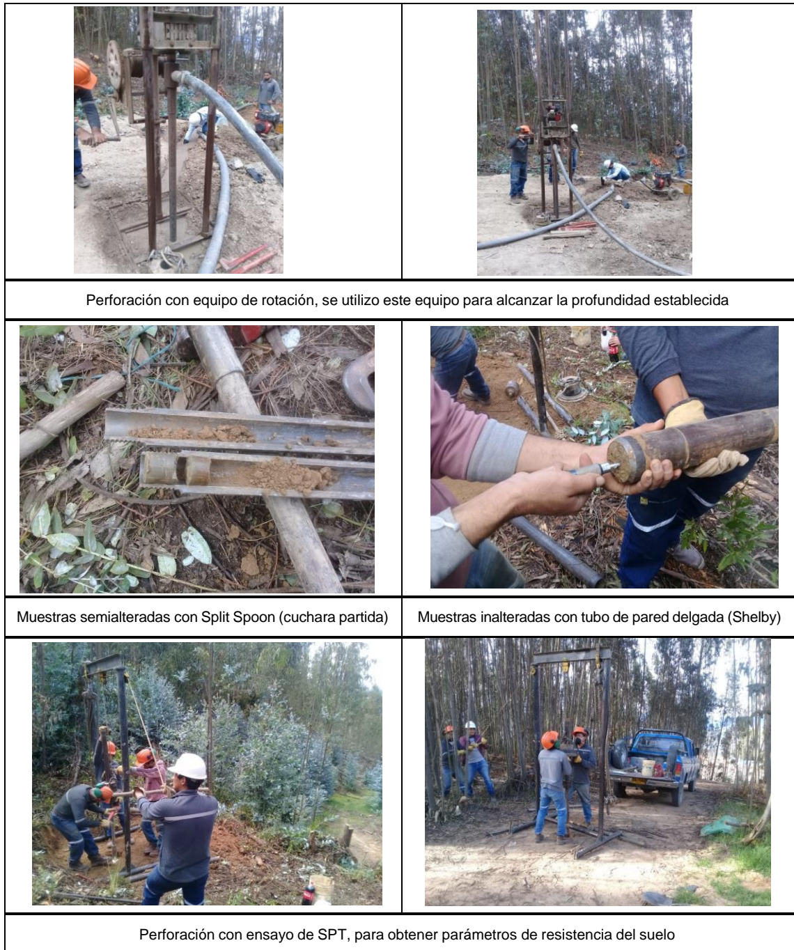
Ilustración 17: Registro fotográfico estudio geotécnico o de suelos.
