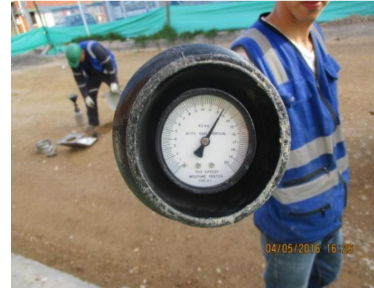
Fotografía 25: Toma de densidades en la capa de Subbase granular tipo c.
