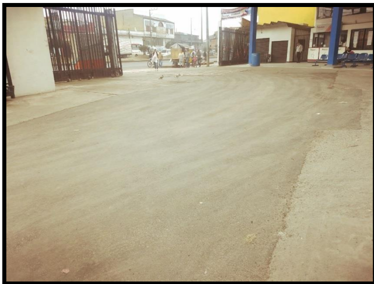
Figura 74. Fotografía tomada 20 de febrero de 2019, a 7 meses de terminación y entrega.
