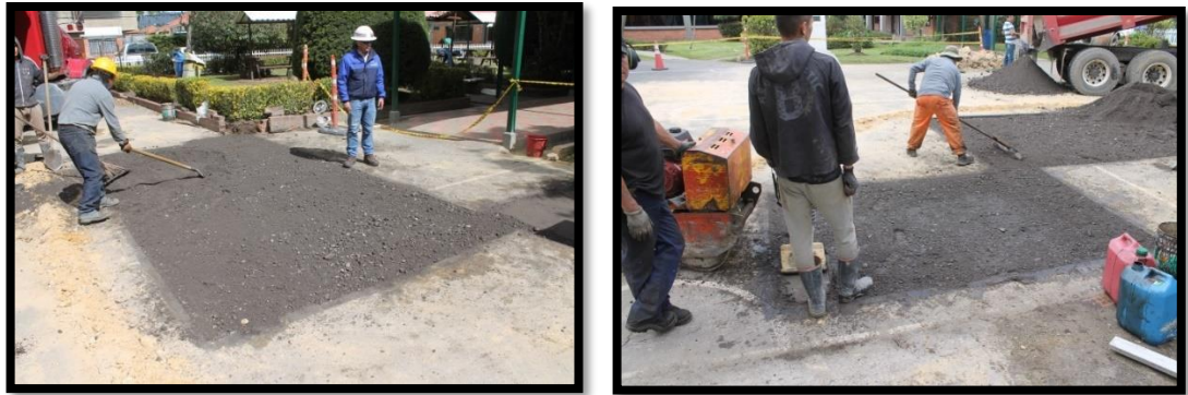
Figura 64. Extendida de la mezcla MAN VERDE.
