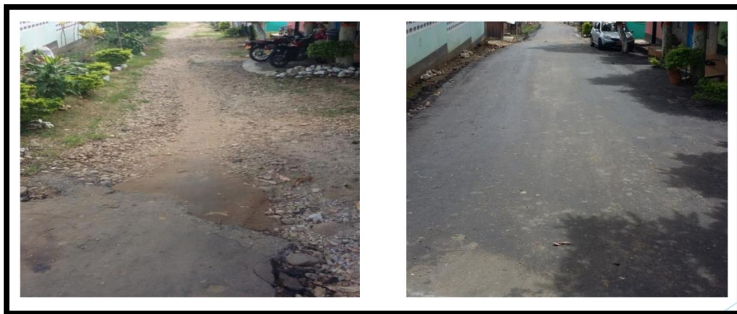
Figura 7: Rodadura con Mezcla Asfáltica Natural (MAN), calle 2ª con 4, municipio de El Doncello, departamento de Caquetá.
