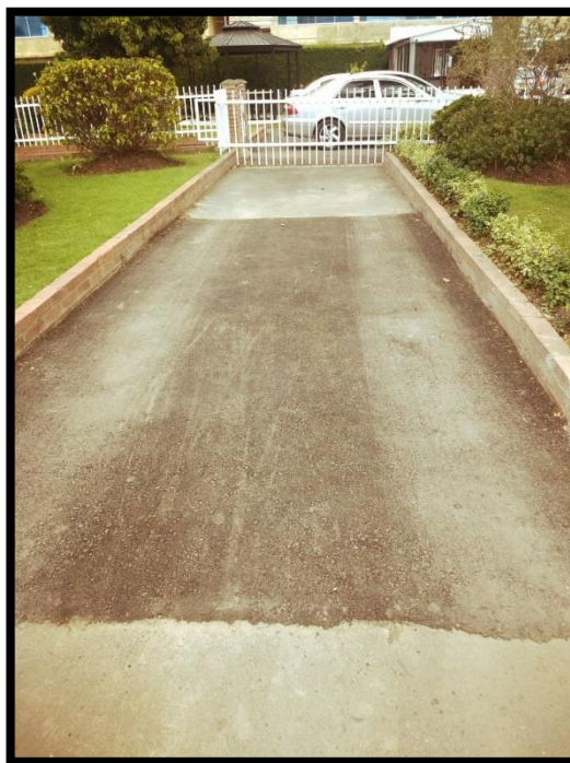
Figura 69. Fotografía tomada 22 de febrero de 2019, a 8 meses de terminación y entrega.
