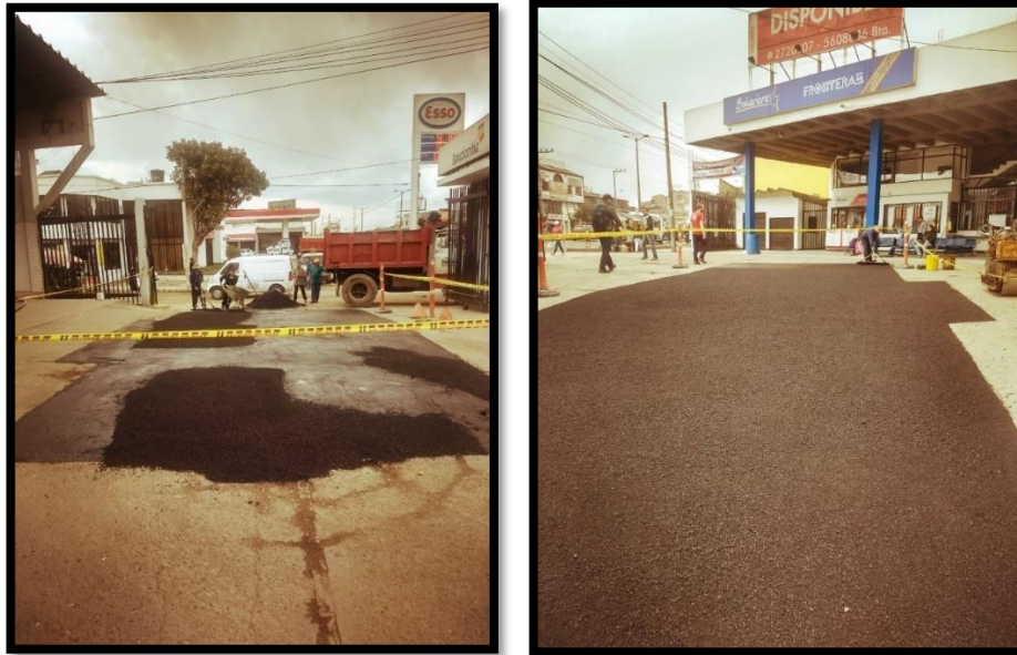
Figura 72 Extendida y compactado de MAN VERDE
