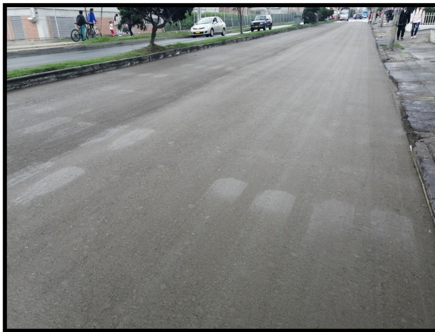
Figura 78. Experiencias en los trabajos de la calle 15 entre carreras 4 y 16 en el municipio de Facatativá, Cundinamarca.
