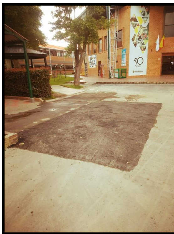
Figura 67. Fotografía tomada 22 de febrero de 2019, a 8 meses de terminación y entrega.
