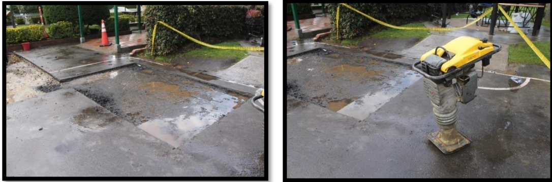
Figura 60. Compactación de la rasante de los bacheos localizados.
