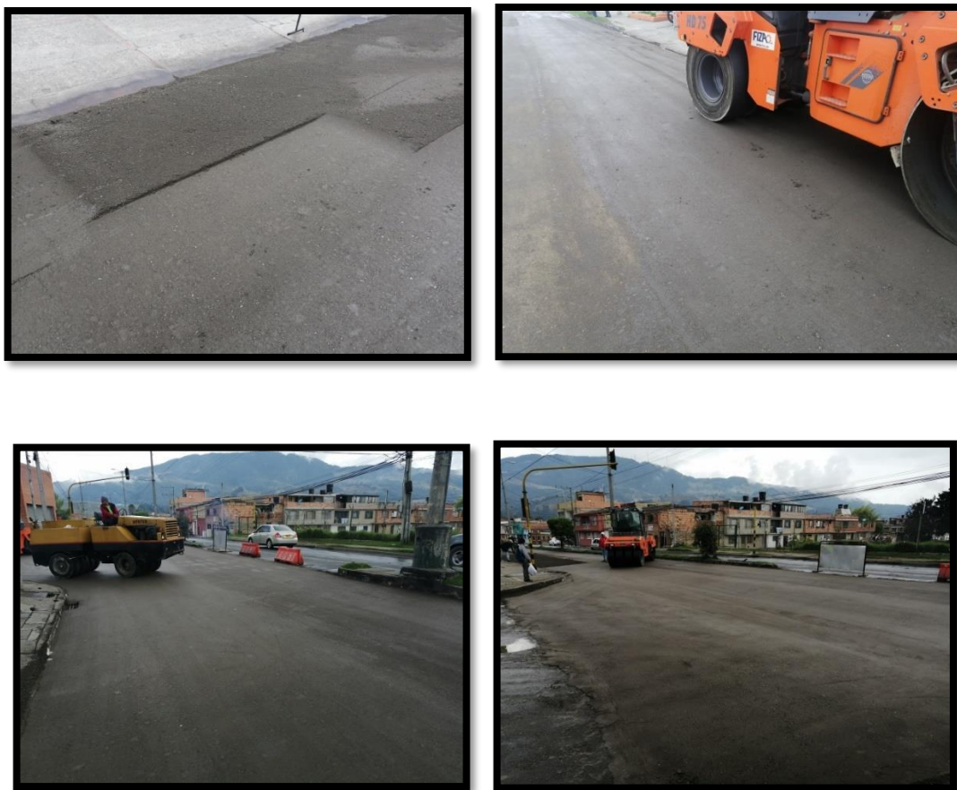
Figura 77. Extendida y compactada de 150 m 3 de Mezcla Asfáltica Natural (MAN).
