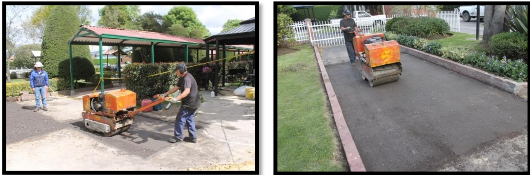
Figura 65, 67. Compactación de la mezcla MAN VERDE.
