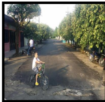
Figura 6: Rodadura con mezcla asfáltica natural (MAN), Municipio de El Doncello, departamento de Caquetá.
