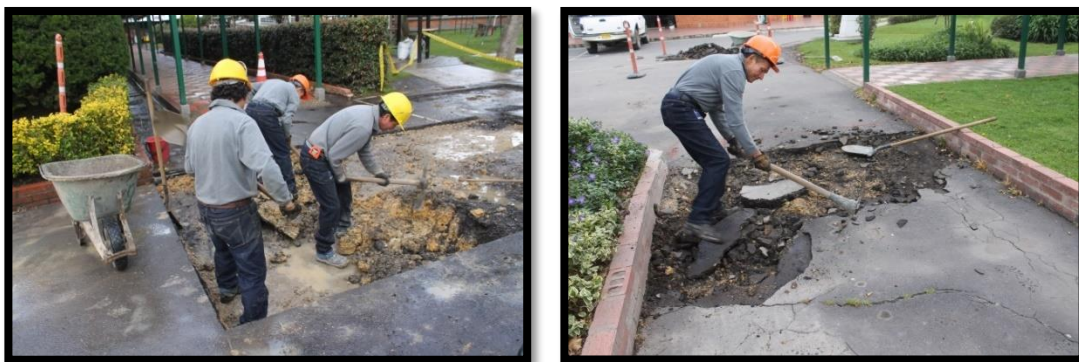
Figura 59. Demolición y cargue de escombros procedentes del asfalto deteriorado.
