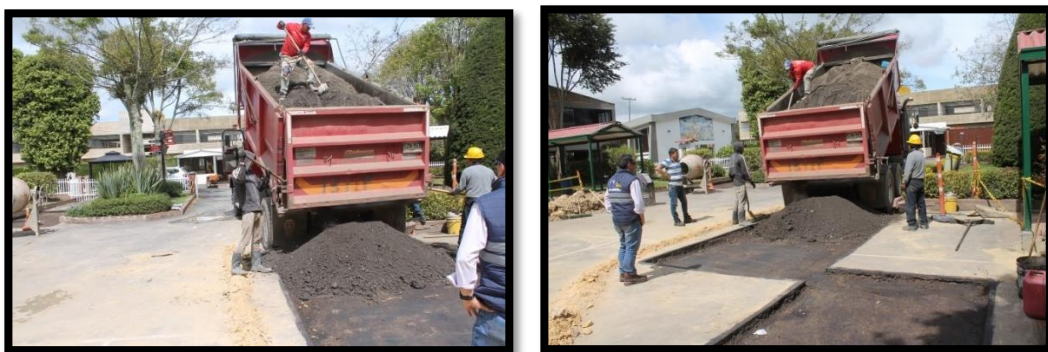
Figura 61. Imprimación de los sitios a intervenir y descargue de la Mezcla Asfáltica Natural (MAN).
