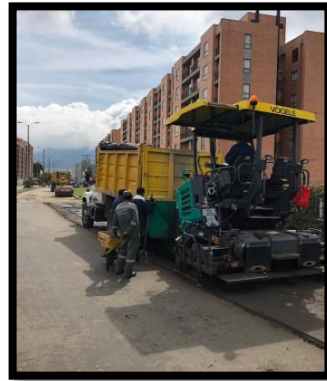
Figura 5: Extendida de Mezcla Asfáltica Natural (MAN).
