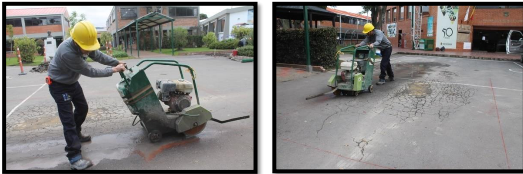
Figura 58. Marcado y corte del asfalto deteriorado para reparcheo con MAN VERDE.
