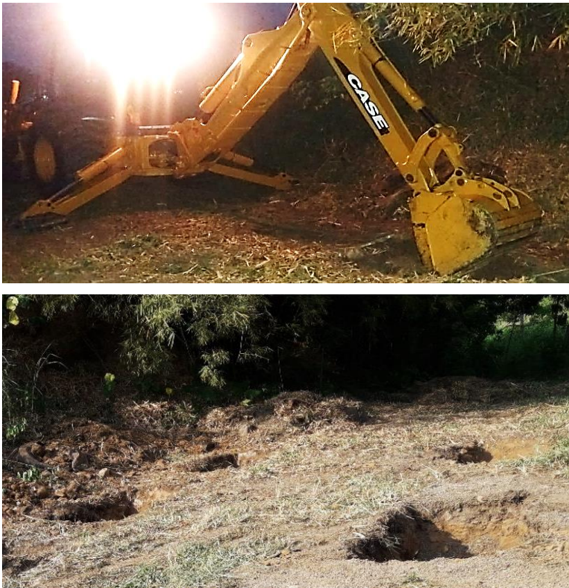
Anexo 4. Excavación de los humedales
