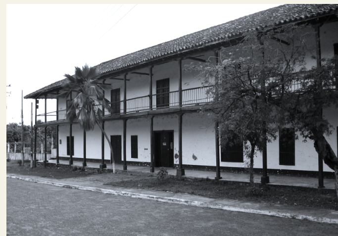
Antigua casa inglesa de Ambalema. Fotografía por D. Correa (2009) Adaptado de De las pocas casas de dos pisos en el casco histórico .
