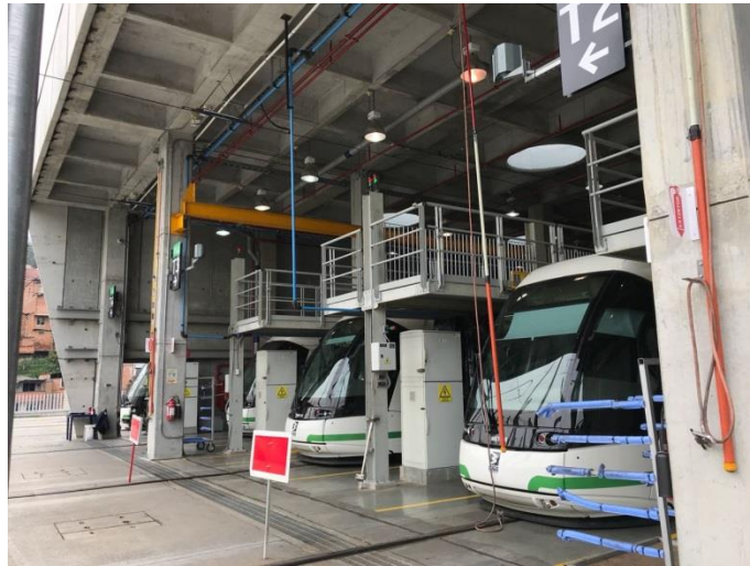
Ilustración 33 Zona de mantenimiento.
