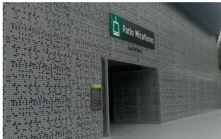
Ilustración 29 Entrada para el personal Patio Miraflores
