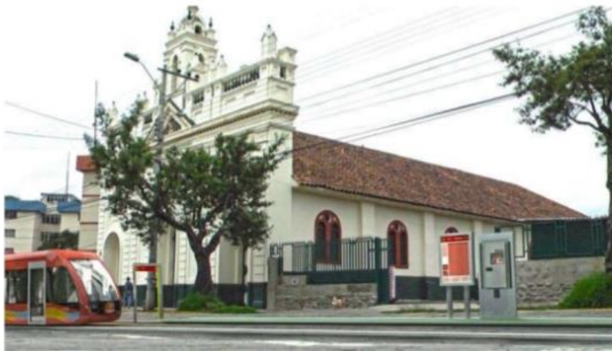
Ilustración 26 Estación de anden lateral Centro Histórico.
