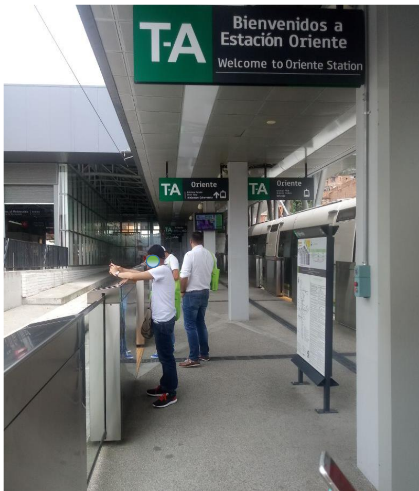
Ilustración 27 Estación de oriente Tranvía de Ayacucho
