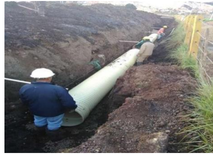
Colocación de Tubería 2
