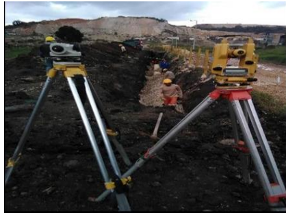
Colocación de Tubería 1
