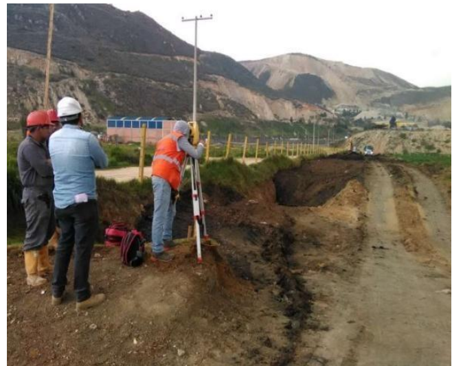
Fotografía 3: Localización y replanteo 2
