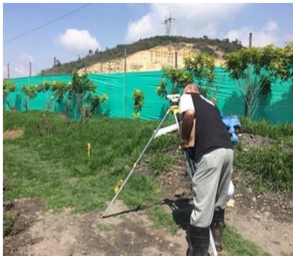
Fotografía 2: Localización y replanteo
