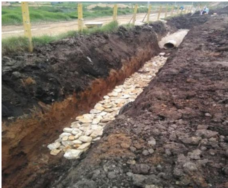
Colocación de piedra Rajón 2
