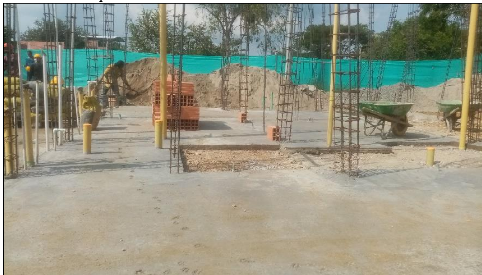
Figura 13. Fundición de piso
