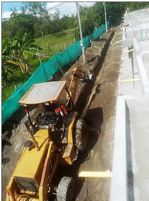
Figura 43. Excavación para colectores de alcantarillado
