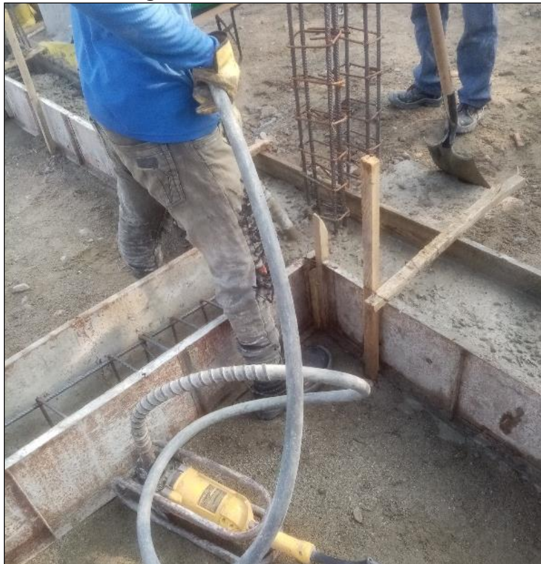
Figura 9. Vibrado mecánico en viga de cimentación
