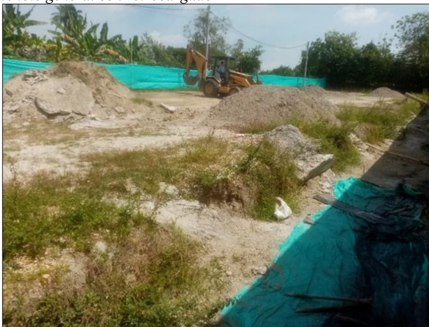
Figura 4. Descapote lote general con retrocargador
