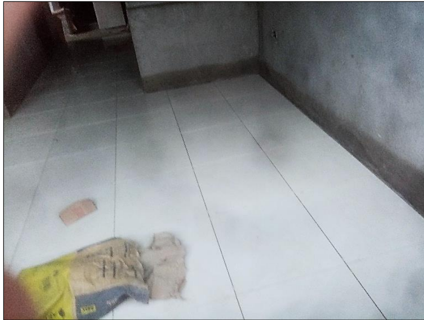
Figura 34. Instalación de acabado de piso
