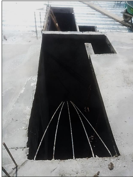
Figura 26. Vacío para escalera y continuación de acero para armado
