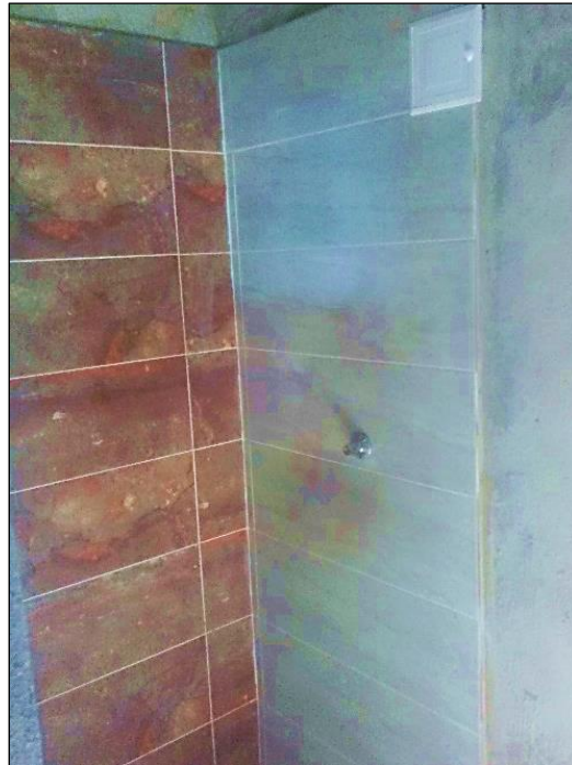
Figura 35. Enchapado paredes de baño
