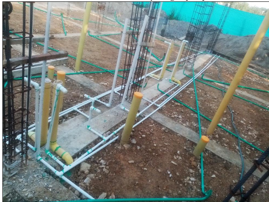
Figura 12. Instalación redes hidráulicas, eléctricas y de gas por piso
