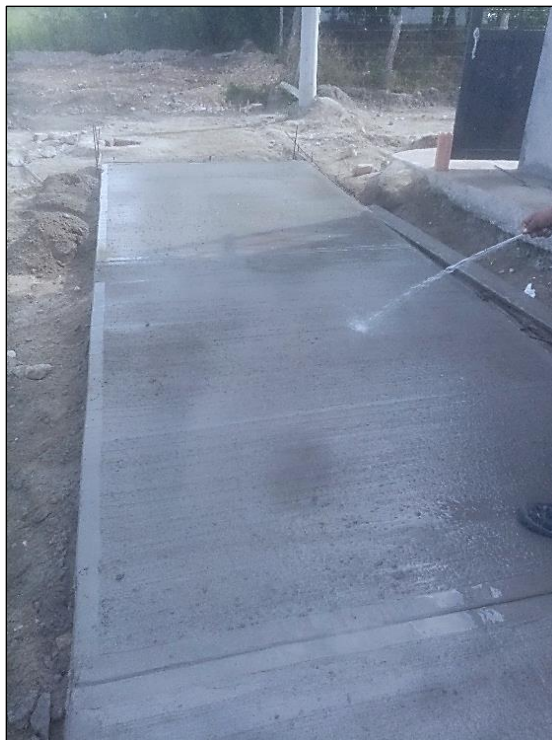
Figura 49. Etapa de curado de tramos de vía
