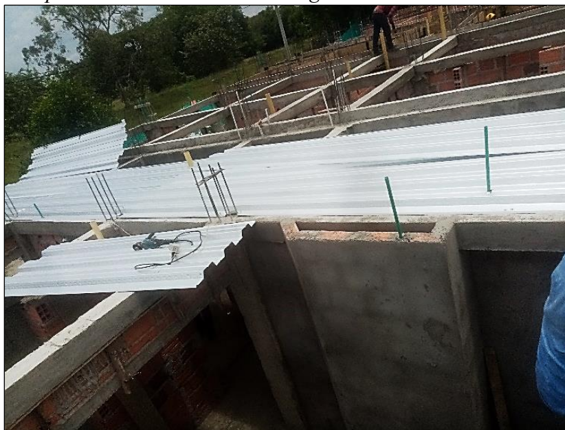
Figura 18. Etapa de pañete debido a retraso de llegada de lámina colaborante
