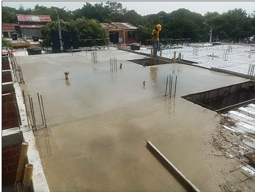
Figura 21. Hormigonado de losa
