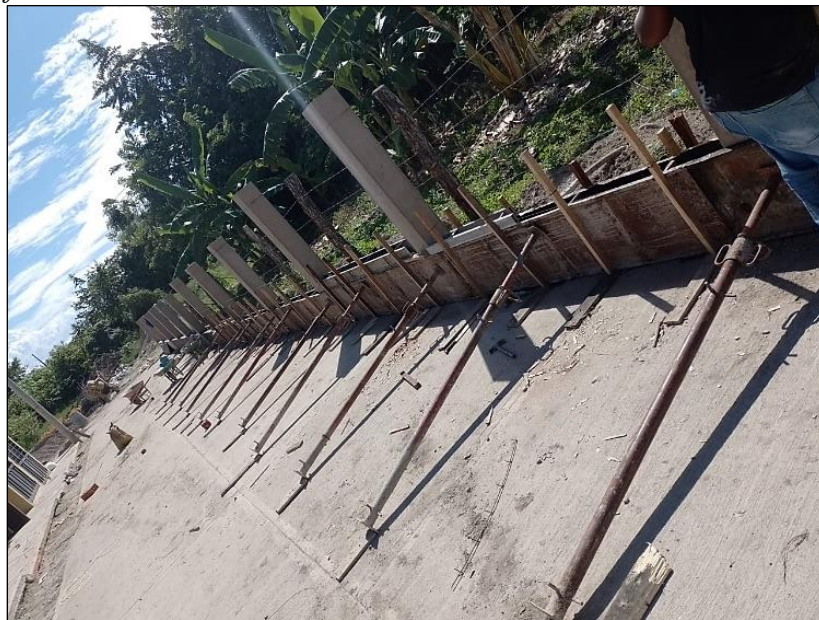
Figura 50. Encofrado muro de cerramiento en concreto
