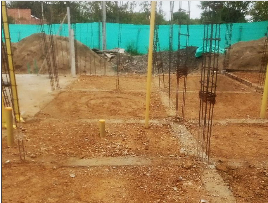
Figura 11. Relleno y compactación
