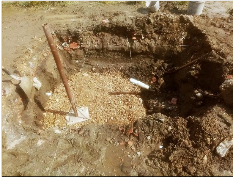
Figura 41. Excavación para pozo de inspección
