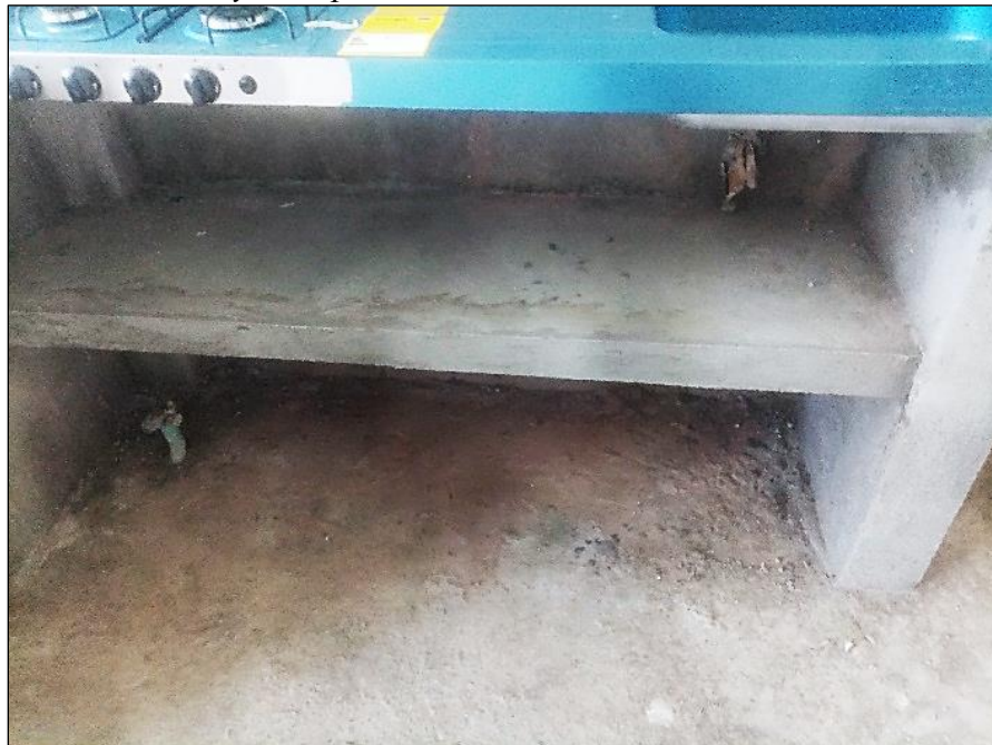
Figura 28. Mesón inoxidable y entrepaño de concreto
