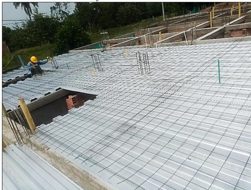
Figura 20. Lámina colaborante armada junto a malla electrosoldada
