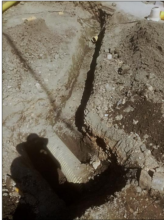
Figura 45. Excavación para acometida sanitaria
