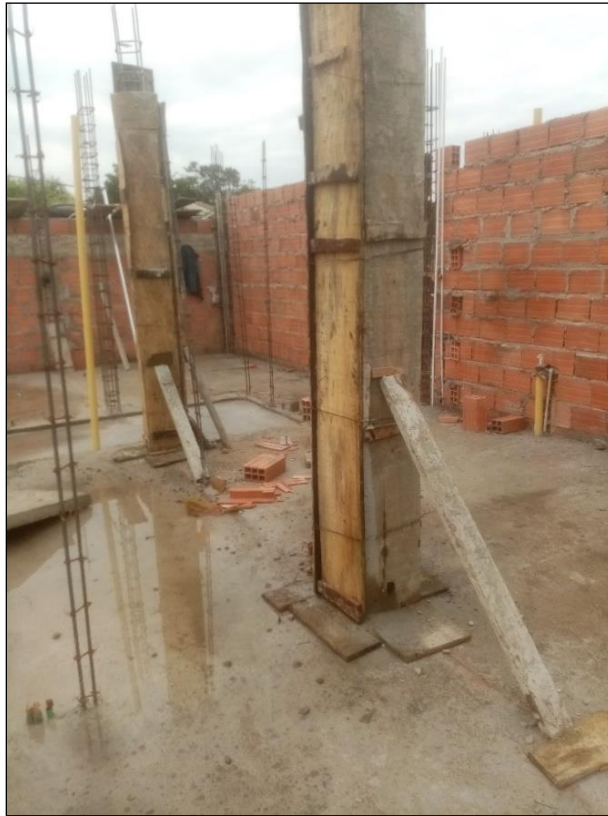
Figura 14. Encofrado de columnas fundidas
