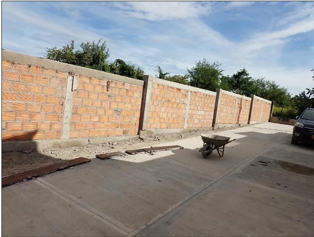
Figura 53. Muro de cerramiento en mampostería finalizado
