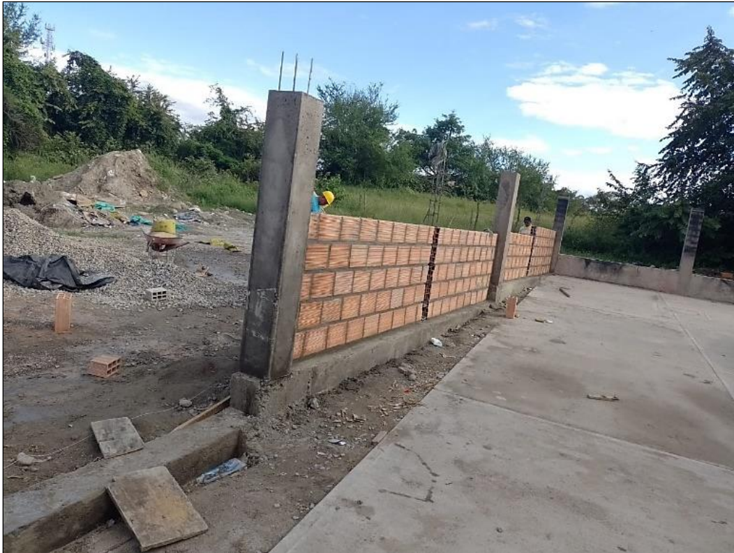
Figura 52. Construcción muro de cerramiento en mampostería
