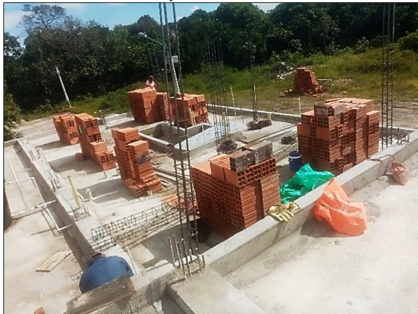
Figura 22. Disposición hilada de ladrillo perimetral
