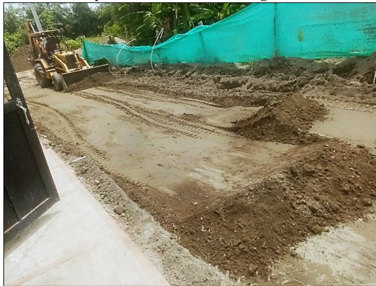
Figura 40. Nivelación de terreno para vía usando retrocargador
