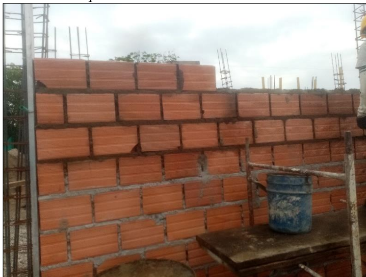
Figura 15. Construcción de mampostería
