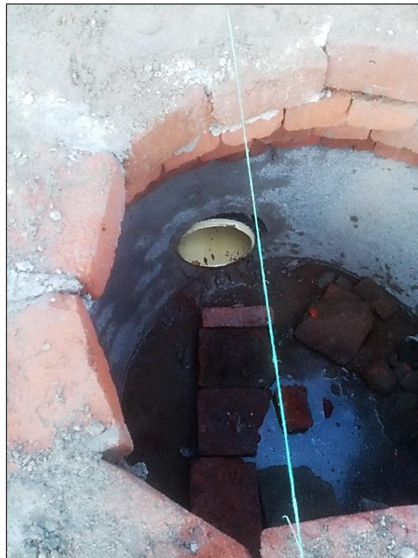
Figura 42. Pozo de inspección construido
