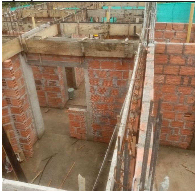
Figura 17. Encofrado viga superior
