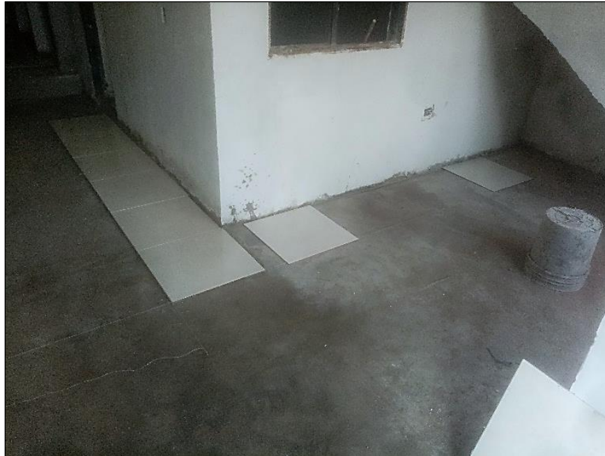
Figura 33. Líneas guía para acabado de piso
