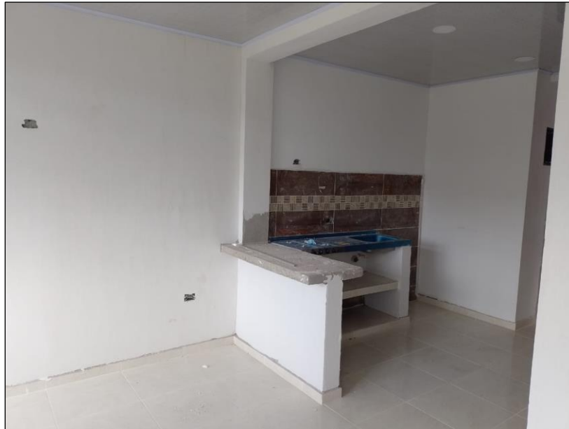
Figura 38. Finalización de estucado
