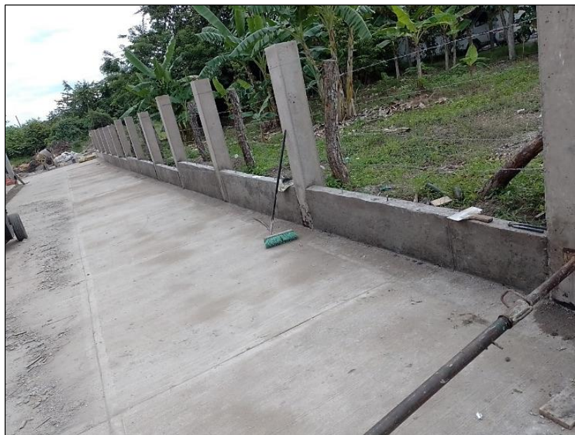
Figura 51. Muro de cerramiento en concreto
