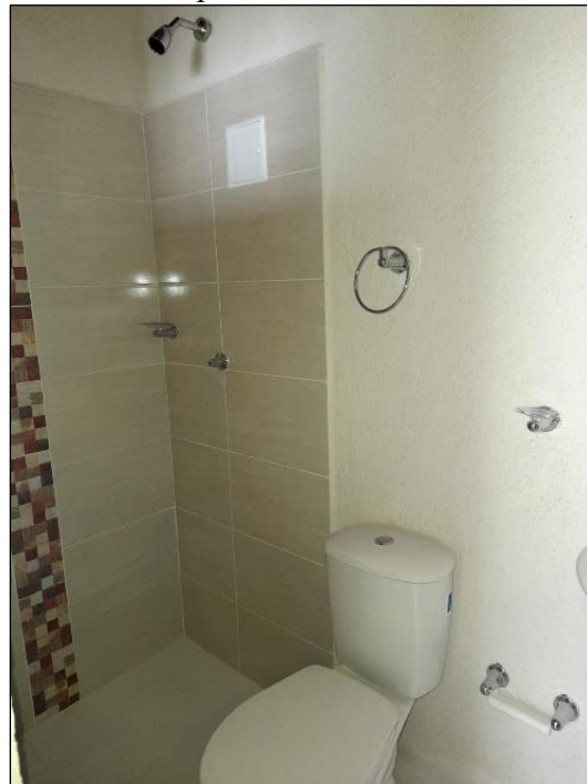
Figura 36. Paredes y piso de baño enchapados
