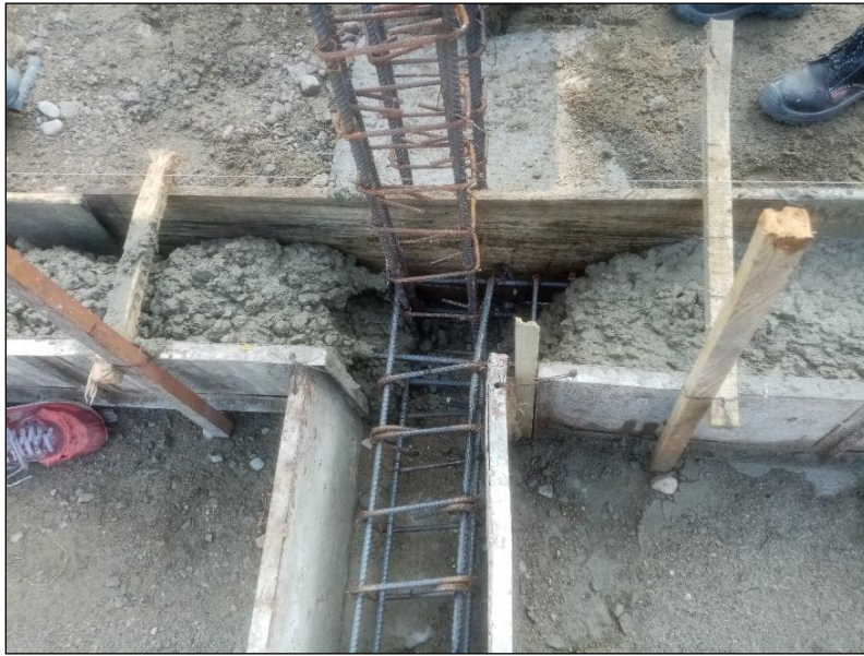
Figura 8. Hormigonado viga de cimentación
