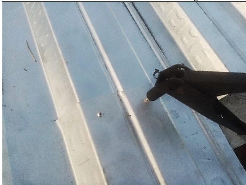
Figura 19. Unión entre láminas colaborantes usando remaches ciegos
