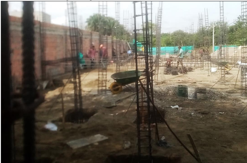
Figura 6. Excavación manual para zapatas
