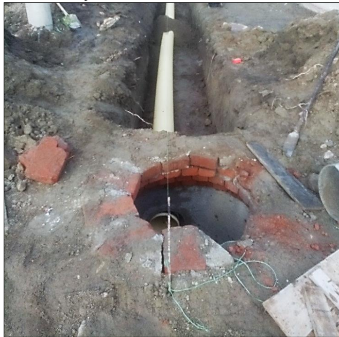
Figura 44. Conexión tubería Novafort 12"
