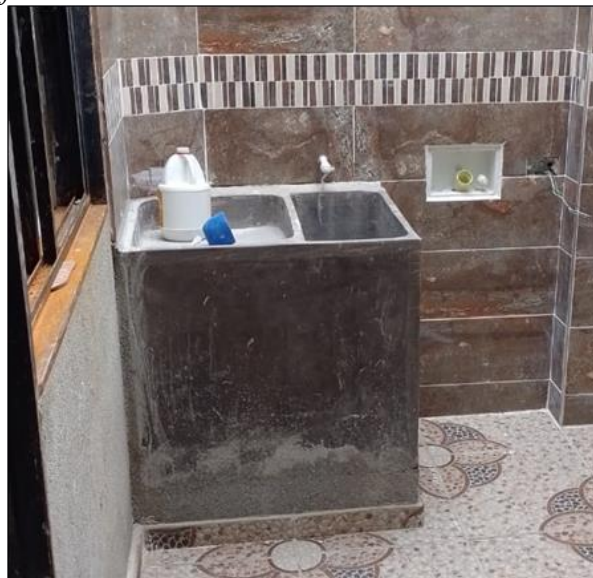
Figura 30. Lavadero prefabricado instalado
