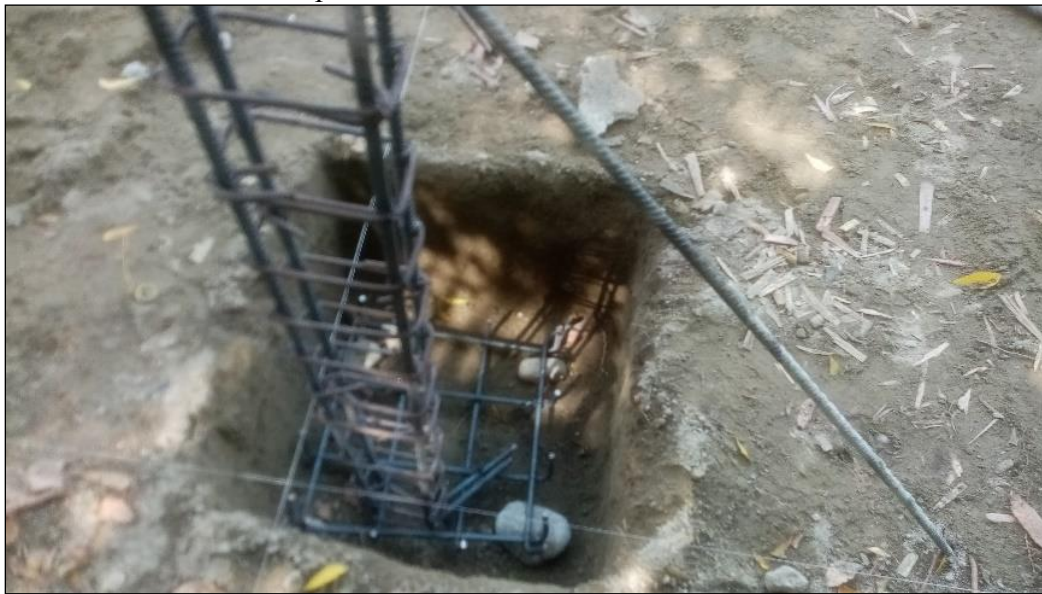
Figura 7. Detalle excavación zapata
