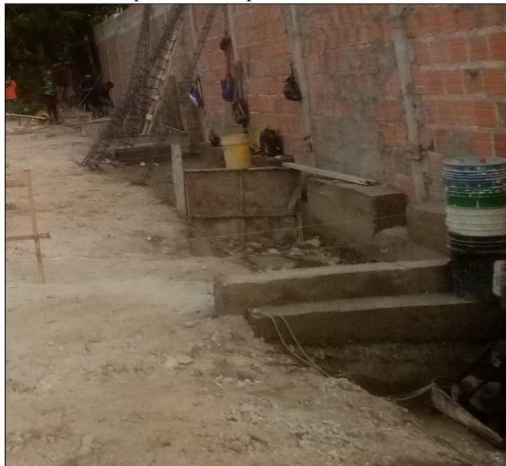
Figura 5. Construcción muro ciclópeo en zona posterior
