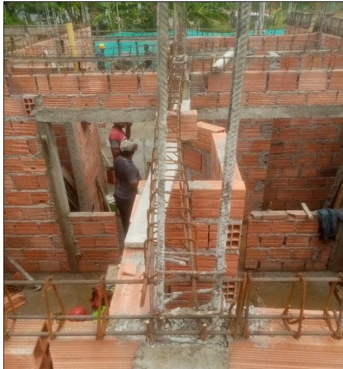
Figura 16. Armado de acero para viga superior
