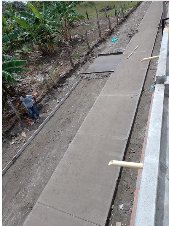
Figura 48. Construcción tramos de vía
