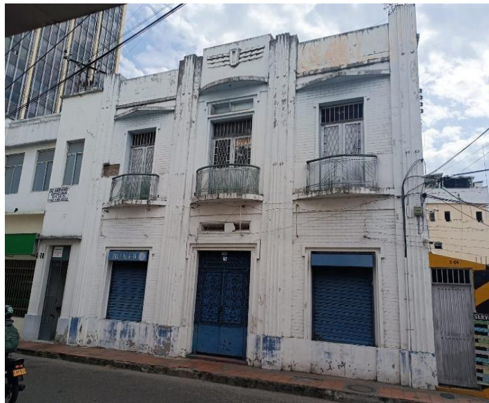
Ilustración 7 Lesión por intemperie lesión 2 Fuente: Elaboración propia
