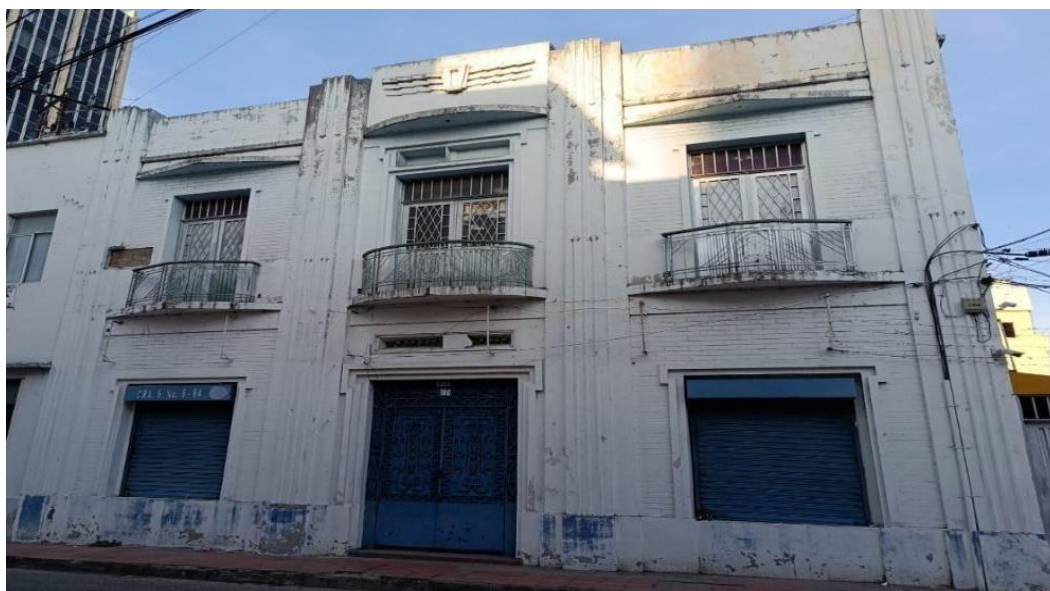
Ilustración 4 Vista actual del proyecto parte interior Fuente: Elaboración propia
