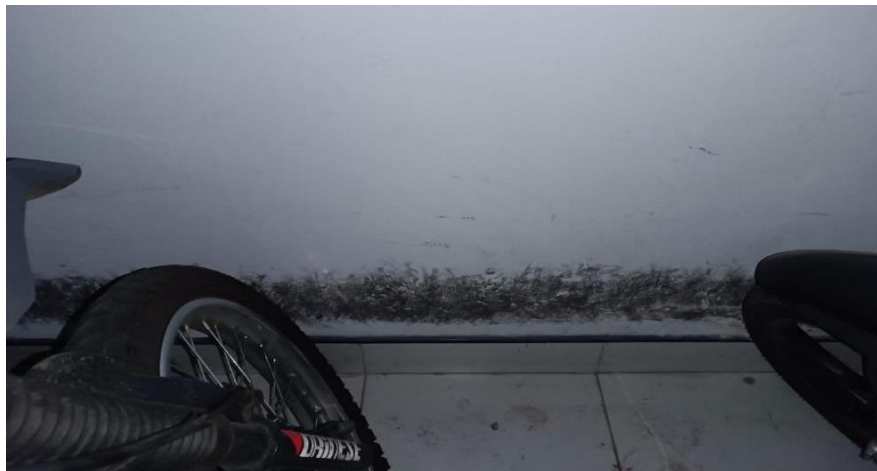
Ilustración 13 Lesión Física Indirecta Ensuciamiento Fuente: Elaboración propia
