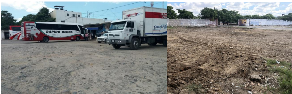
Figura 6. Deterioro del área de acceso y descenso. (2022)
