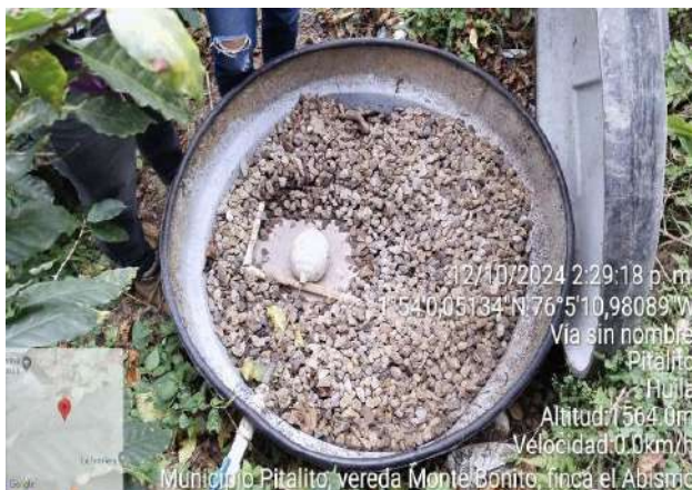
A. Recámara dosificadora con piedra filtro
