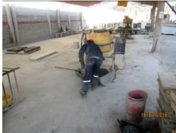
Figura 27. Vertido de la mezcla, para la elaboración de los adoquines.
