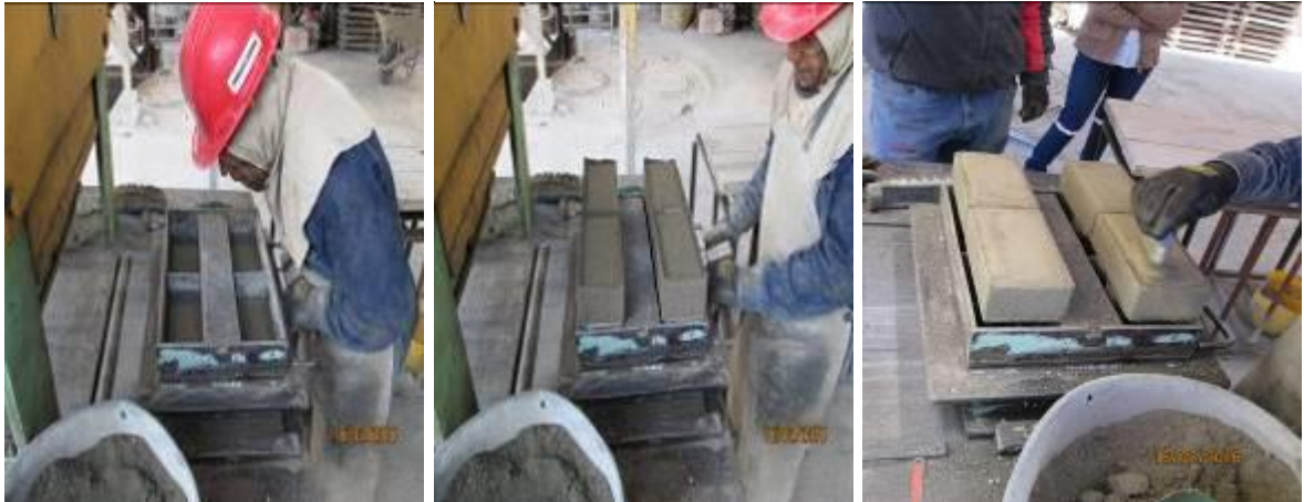
Figura 30. Compactación y acabado final.
