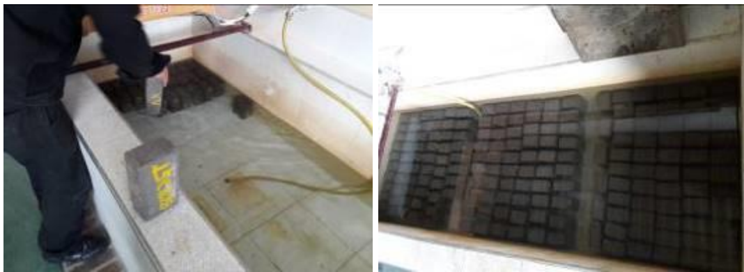
Figura 33. Proceso de Curado.
