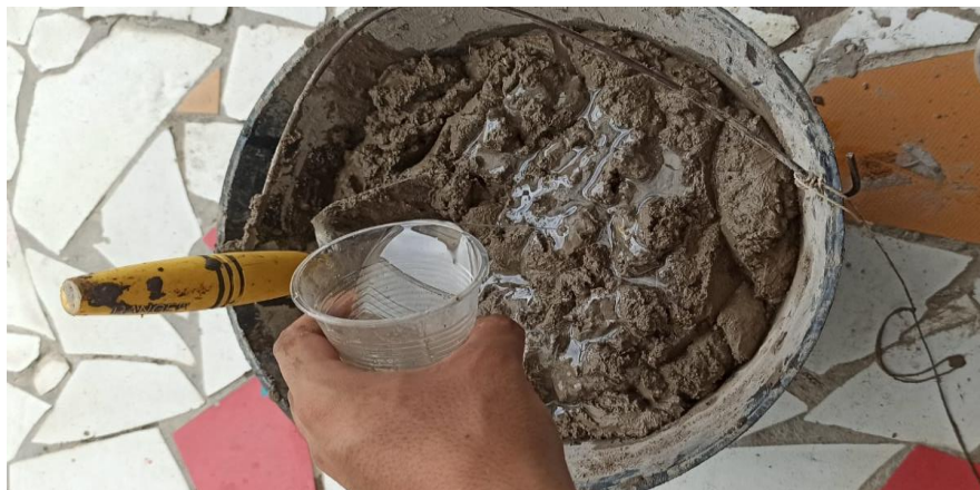
Figura 10 Adición de resina epóxica al mortero tradicional
