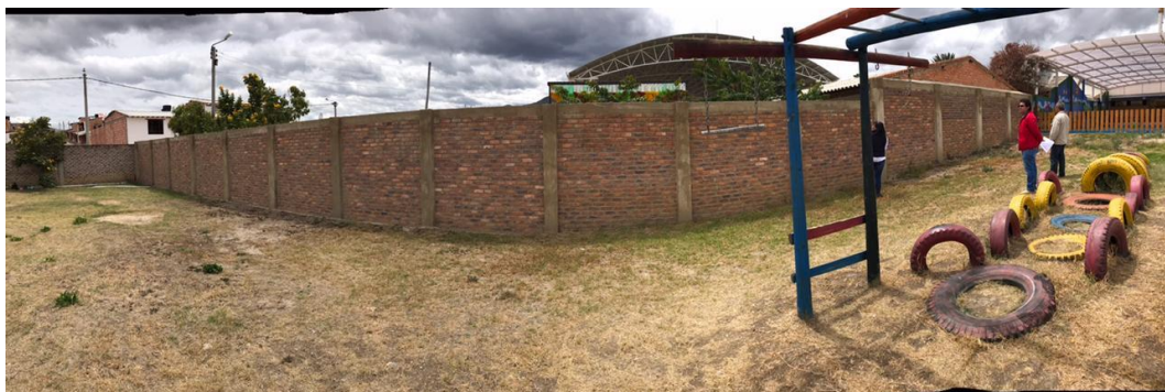
Fotografía 6. Cerramiento del centro de desarrollo infantil
