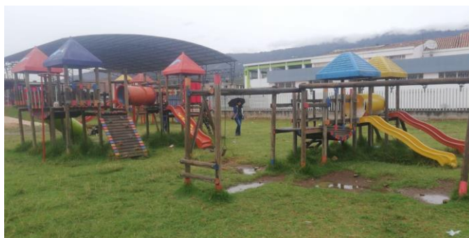
Fotografía 17. Resultado Mantenimiento Centro Educativo Comfaboy
