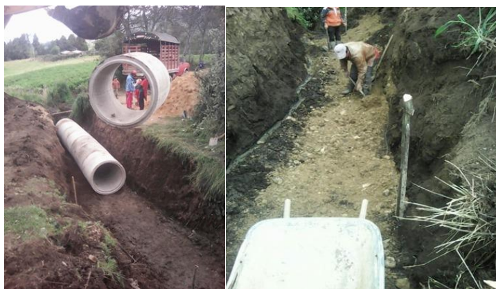
Fotografía 15. Resultado reconstrucción alcantarilla.
