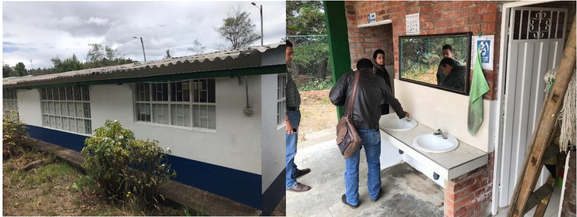
Fotografía 13. Resultado Adecuación de la Escuela - Arboledas
