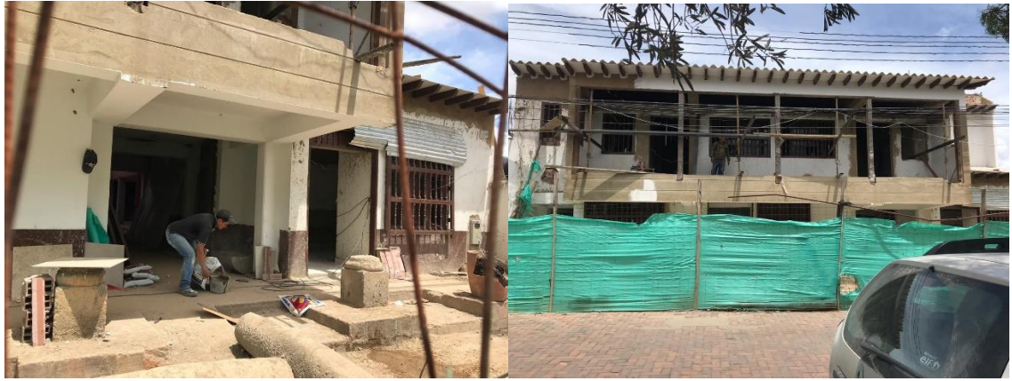
Fotografía 2. Proceso de reforzamiento del palacio Municipal
