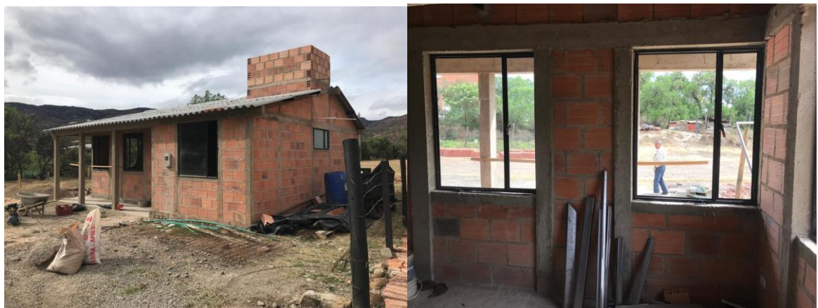
Fotografía 3. Proceso de la construcción de las viviendas.
