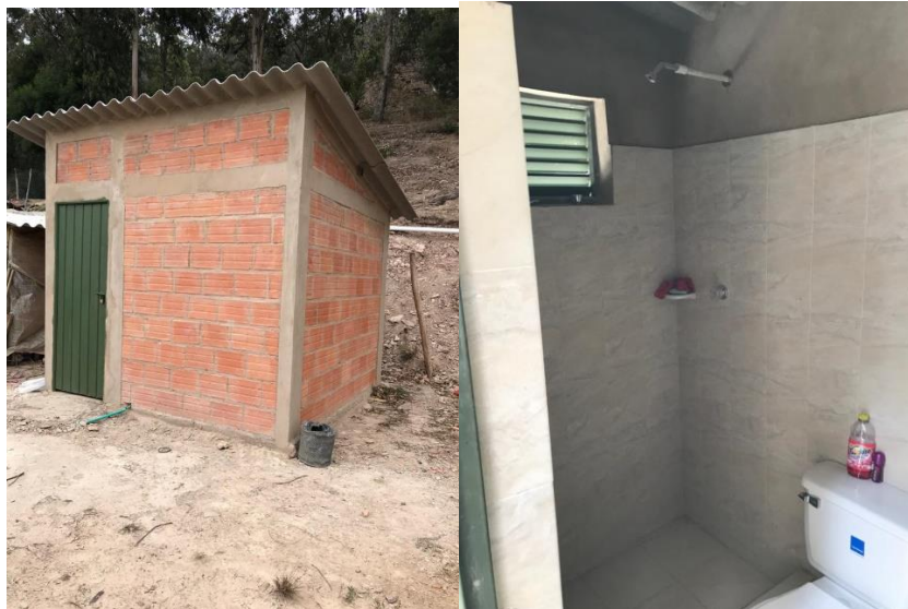
Fotografía 4. Vivienda mejorada en el sector rural del municipio
