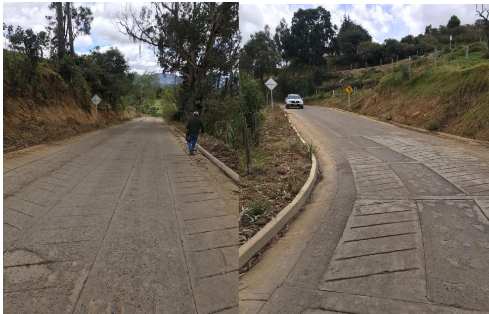
Fotografía 9. Resultado de la instalación de Placa Huella
