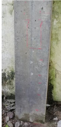
Figura 15 Ensayo de Ferroskan sobre columna en concreto
