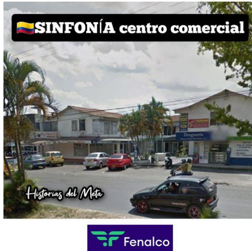
Figura 5 Centro Comercial Sinfonía, en uso, década del 2.000.
