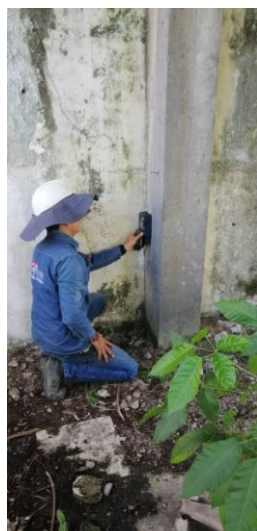
Figura 16 Ensayo de Ferroskan sobre columna en concreto
