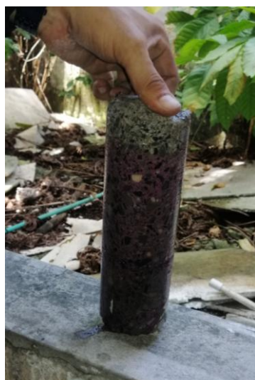
Figura 17 Ensayo de carbonatación en núcleo extraído
