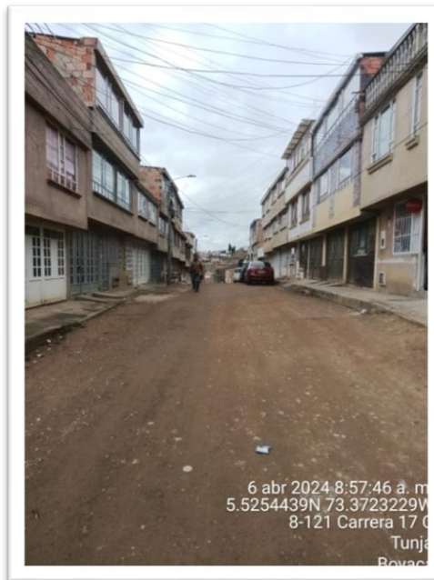
Figura 9. Vía Barrio Mirador Escandinavo
