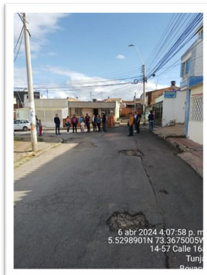
Figura 6. Vía Barrio Centenario
