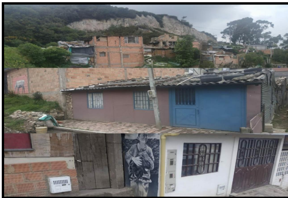
Figura 5 Fotografías de campo - Tipo de viviendas. Fuente: propia, 2021.
