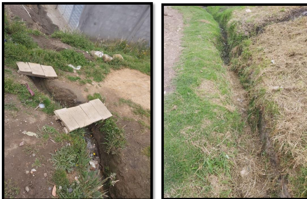
Figura 8 Fotografías de campo – Zanjas para drenaje de aguas grises. Fuente: propia, 2021.
