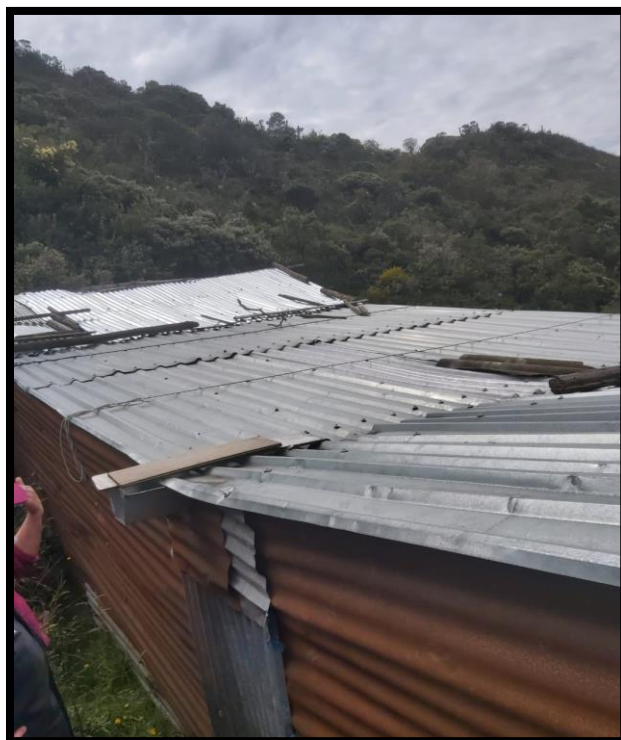
Figura 35 Estado actual de la cubierta vivienda No. 2. Fuente: El autor
