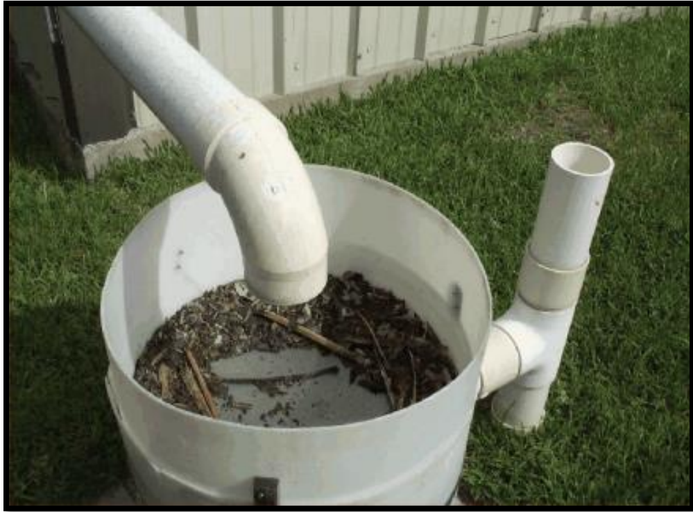
Figura 24 Alternativa de malla para impurezas de primeras aguas. Fuente: Captación de agua de lluvia como alternativa para afrontar la escasez del recurso. Manual de capacitación para la participación comunitaria. (Hernández. F. 2018)
