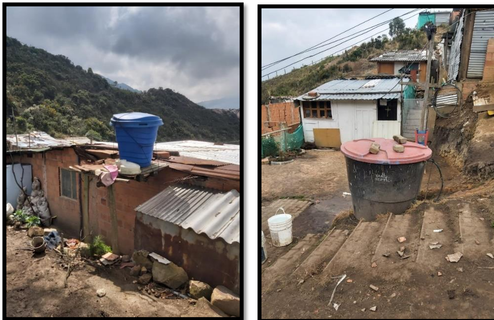
Figura 6 Fotografías de campo - Tanques de almacenamiento por vivienda y comunal.
