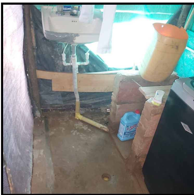
Figura 32 Zona de lavado vivienda No. 1 Fuente: El autor
