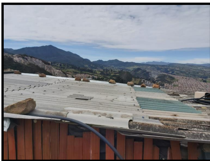
Figura 34 Estado actual de la cubierta vivienda No. 1. Fuente: El autor
