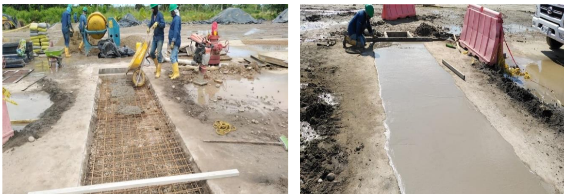
Ilustración 15 Suministro de concreto para placa Akira 17.
