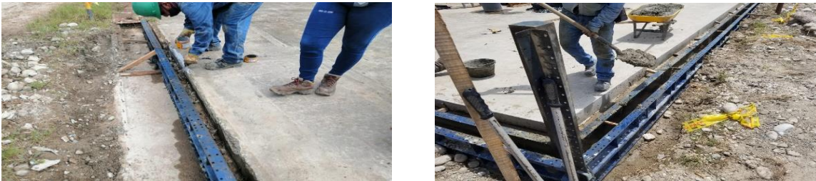
Ilustración 21 Cárcamo Akira Sur.
