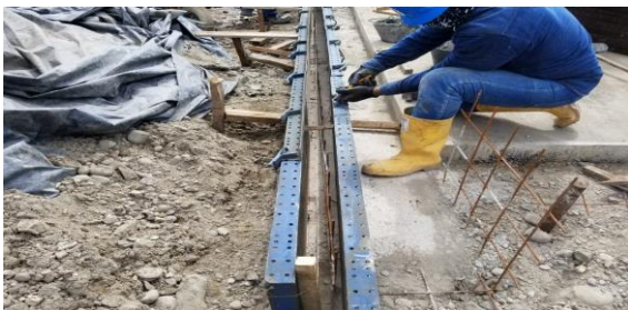
Ilustración 20 Placa de generación.
