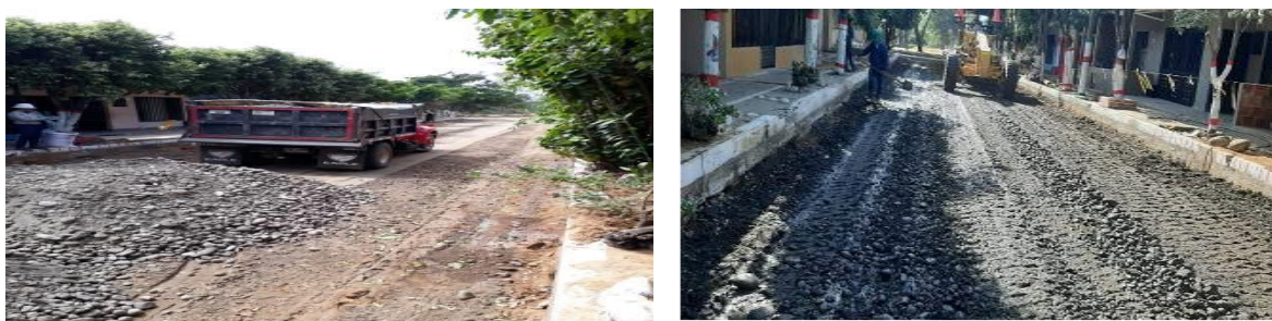
Ilustración 8 Suministro material subbase granular.
