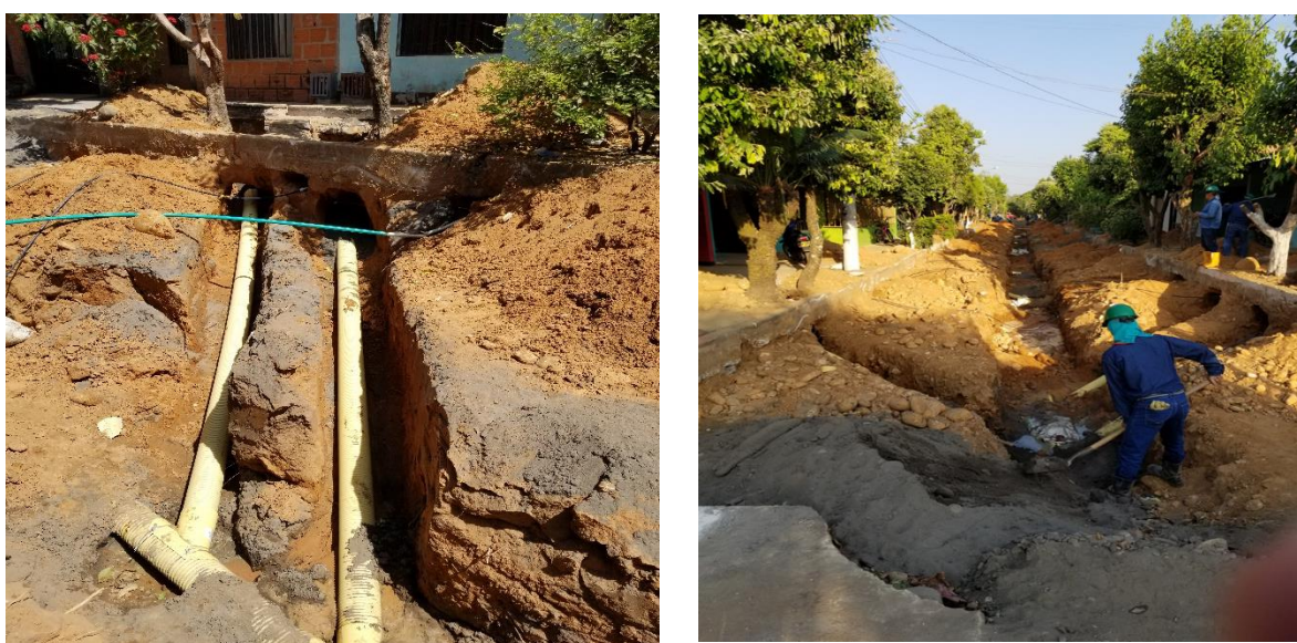
Ilustración 7 Instalación tuberías sanitaria.
