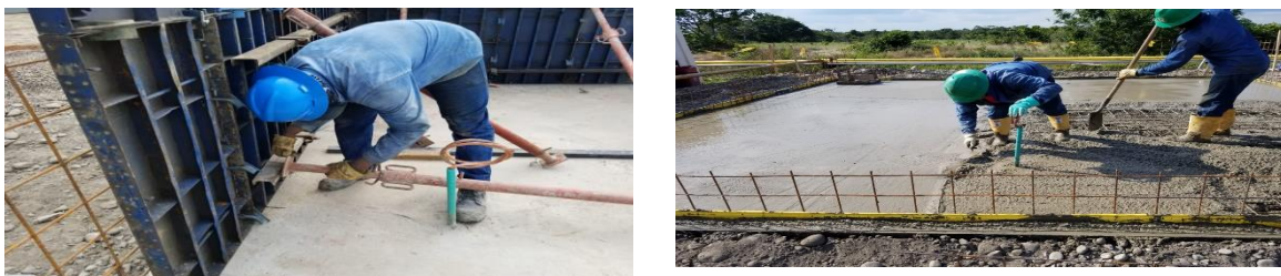
Ilustración 17 Vaciado de concreto.
