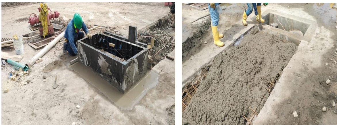
Ilustración 14 Construcción cajas Riser.
